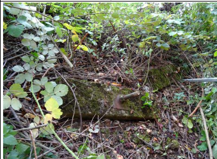
Beispiel bestehende Böschungsverdübelung; GEWI-Nagel Ø 40 mm
