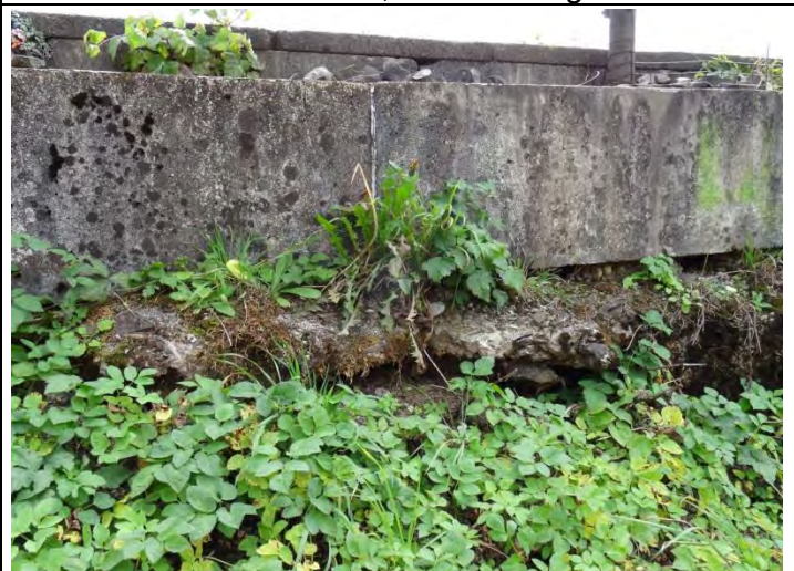
ca. km 22'80: Versatz unterhalb Ribbertplatten, wegen Böschungskriechen
