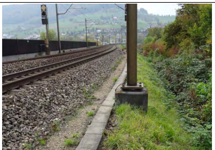
Beispiel Mastfundament ca. km 22'76; Fundamente zeigen keine Anzeichen für stärkere Verkippungen
