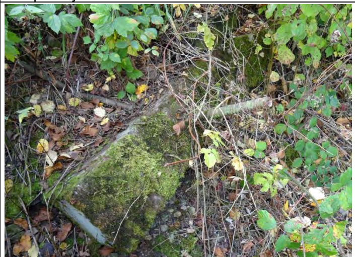
Beispiel verdrehtes Dübelelement in der Böschung
