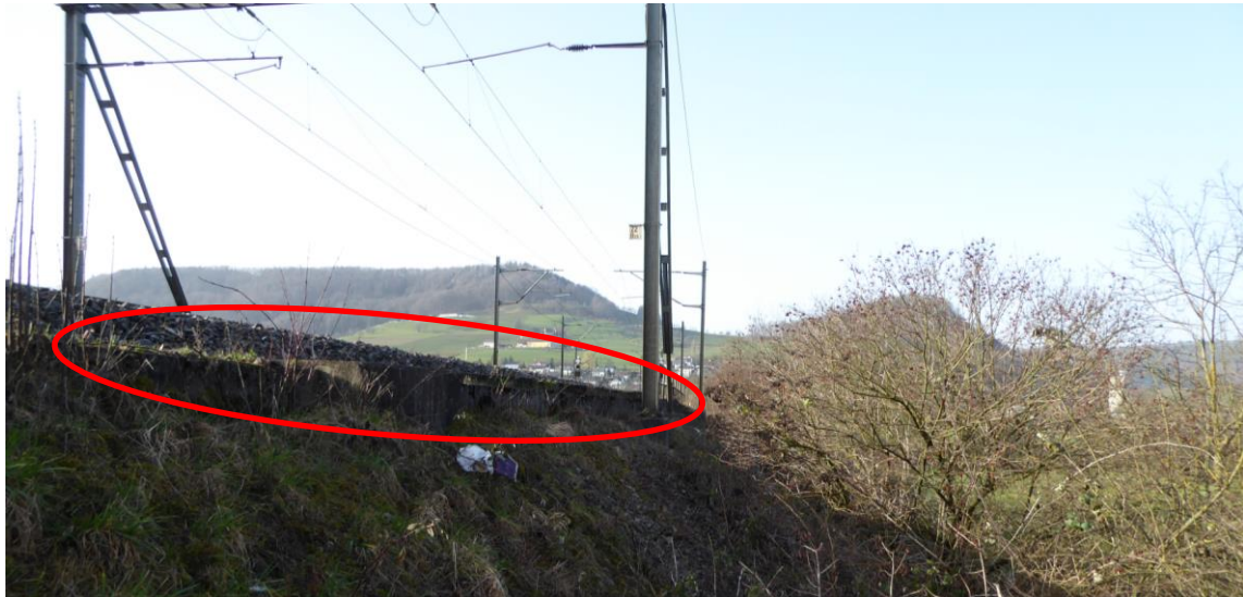
Abbildung 7 Bestandsfoto vom Dammschnitt 5 vom 26.02.2021 mit Sicht auf frei liegenden Kabelkanal in rot
