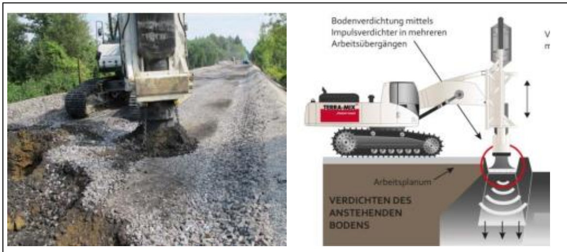
Abbildung 34 Dynamische Intensivverdichtung: Links (Beispiel Dammsanierung), Rechts (Wirkungsweise) [18]
