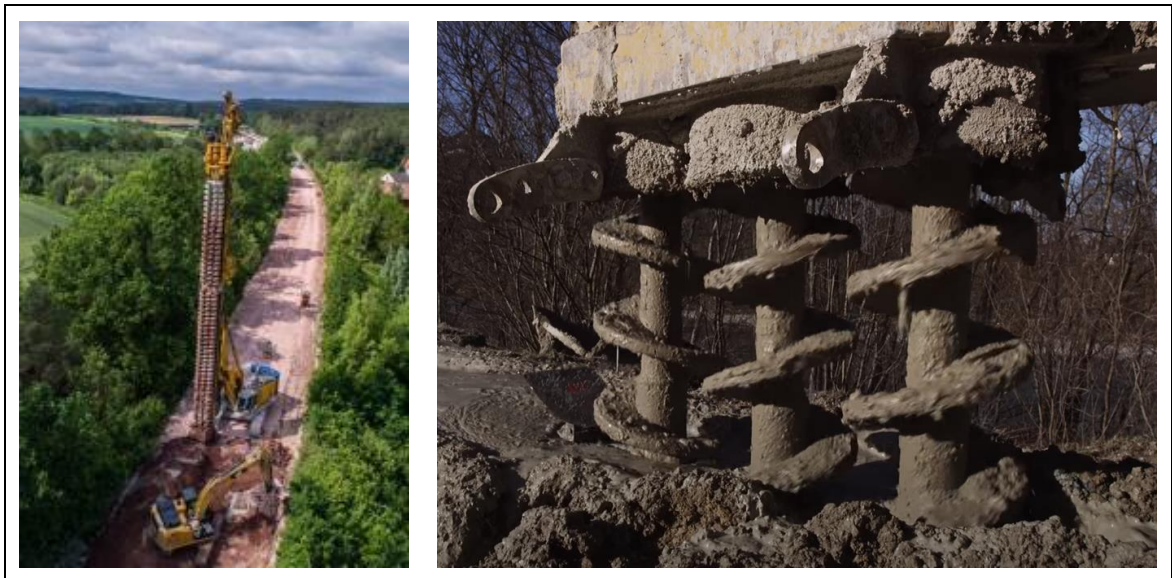
Abbildung 37 Mixed-In-Place: Links (Übersicht Bohrgerät), Rechts (Detail Bohrschnecken) [20]
