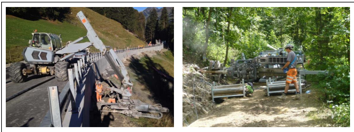
Abbildung 40 Drainagebohrungen: Links (Bagger mit Bohraufsatz und Bohrung von oben), Rechts (Kleinbohrgerät mit Bohrung von unten) [24]
