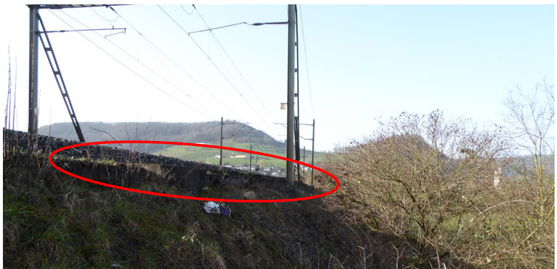
Abbildung 9 Bestandsfoto vom Dammabschnitt 5 vom 26.02.2021 mit Sicht auf frei liegenden Kabelkanal in rot
