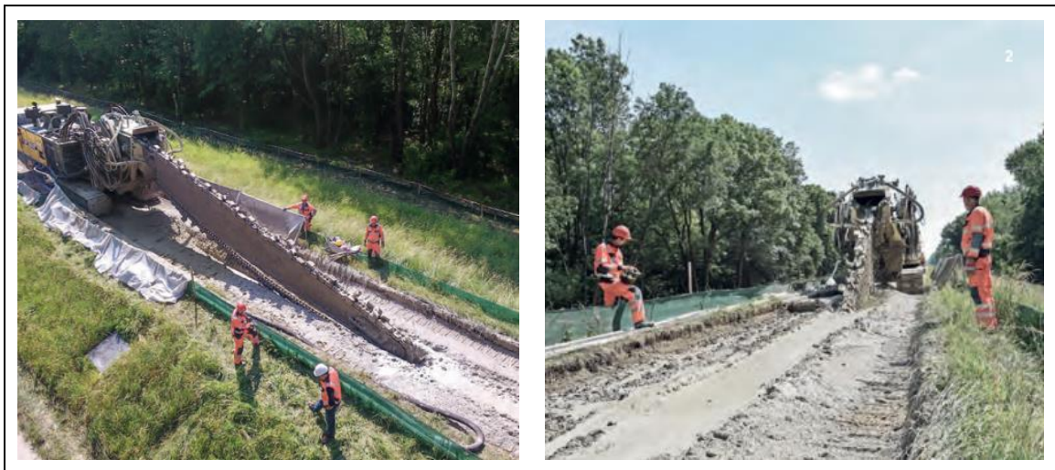
Abbildung 38 Fräs-Misch-Injektionsverfahren: Links (Beispiel mit Ansicht von oben), Rechts (Beispiel mit Ansicht von vorne) [21]
