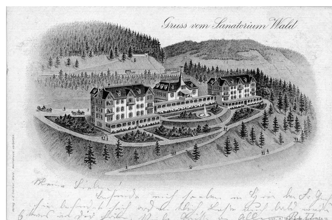
Die Zürcher Heilstätte für Lungenkranke in Wald wurde 1898 von den Architekten Jung & Brüdler erbaut. Die symmetrisch angelegte Anlage besteht aus drei Baukörpern, mit vorgelagerten Liegehallen im Charakter von eingeschossigen Veranden.
