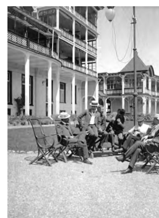
Die kontinuierlich erweiterten Liegehallen in Leichtkonstruktion prägen die Gesamterscheinung und lassen eine tiefe Fassade entstehen. Jugendstil Sanatorium Schatzalp in Davos, 1900 von Lucius Spengler und Edward Neumann erbaut.
