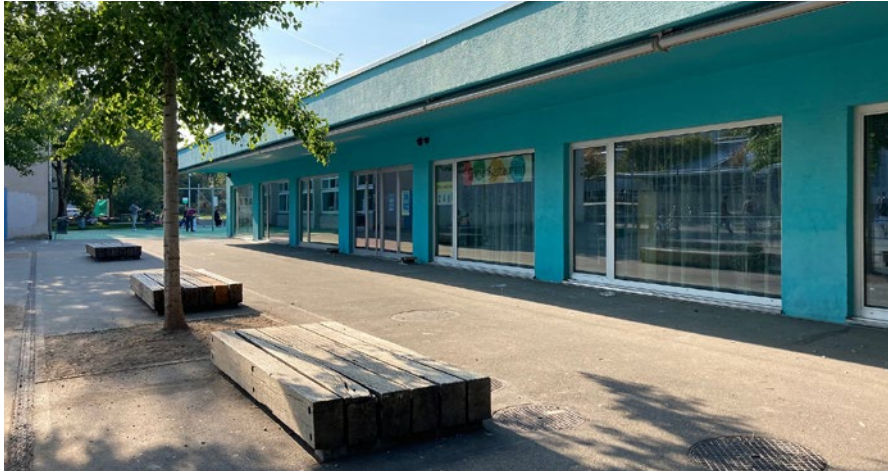
Schulanlage Luchswiesen, Erweiterung Covas Hunkeler Wyss mit Rotzler Krebs Landschaftsarchitekten, Kindergarten- und Betreuungsgebäude (AHB, 2020)
