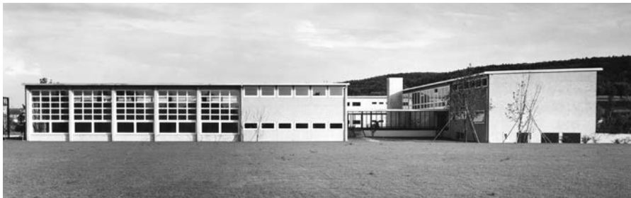
Schulanlage Luchswiesen, Max. P. Kollbrunner, Ansicht von Norden, 1957 (BAZ)
