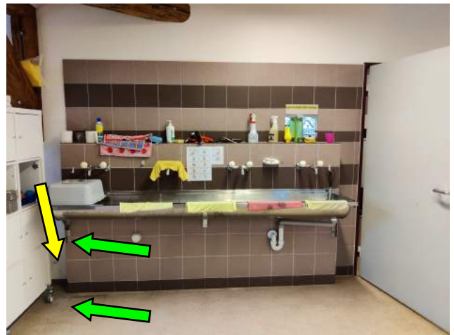
DG, Zimmer West, Detail Lavabo PK1: Fliesenkleber Wand braun, kein Asbest VP1: Innenverputz Zimmer MP, asbesthaltig BB1: Bodenbelag beige, kein Asbest
