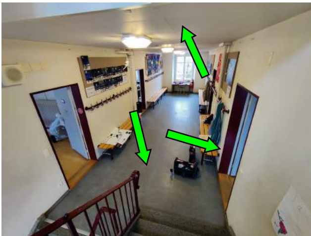
1.OG, Gang Bodenbelag grau baugleich BB2, kein Asbest VP2: Innenverputz Treppenhaus MP, kein Asbest Deckenplatten baugleich Iso1, kein Asbest
