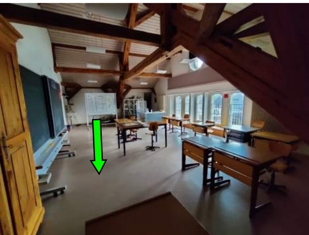
DG, Zimmer Ost Bodenbelag beige baugleich BB1, kein Asbest
