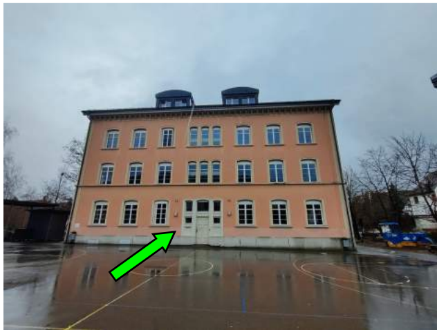
Schulhaus Schanz, Nordfassade VP3: Aussenverputz MP, kein Asbest
