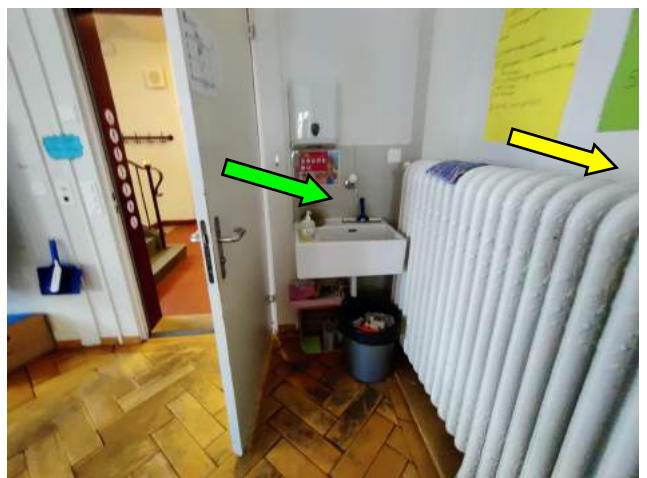
EG, alle Schulzimmer baugleich VP1: Innenverputz Zimmer MP, asbesthaltig PK4: Fliesenkleber Wand grau EG
