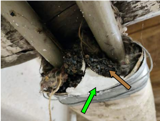
UG, Lagerraum Detail Iso4: Mörtelisolation Leitung, kein Asbest Teerkorkisolation der Leitungen: PAK-haltig (keine Probe)
