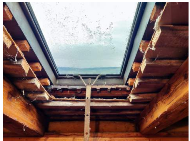
Estrich, Dachaufbau Holzbalken, Holzverkleidung, Pavatexplatten, Ziegel, z.T. mit Glaswollisolation, kein Asbestverdacht
