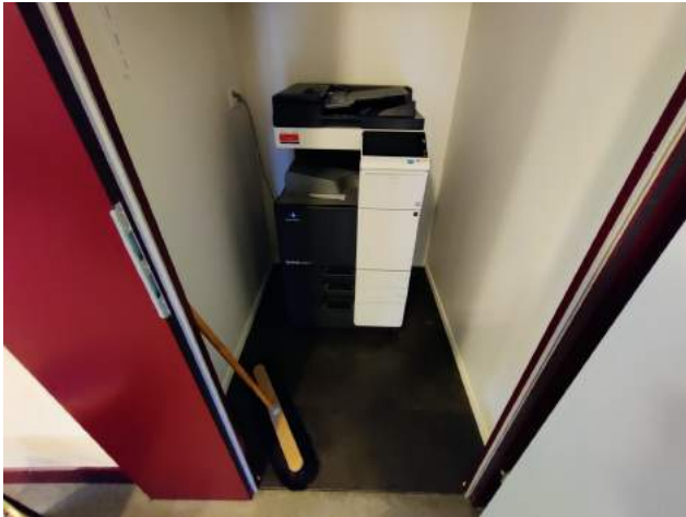
2.OG, Kopierraum Boden aus schwarzem Presskarton/-holzplatten auf Beton, kein Asbestverdacht
