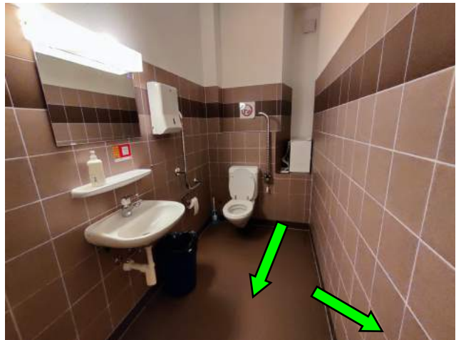
EG, WC PK5: Fliesenkleber Wand braun EG, kein Asbest Boden braun baugleich PK2, kein Asbest
