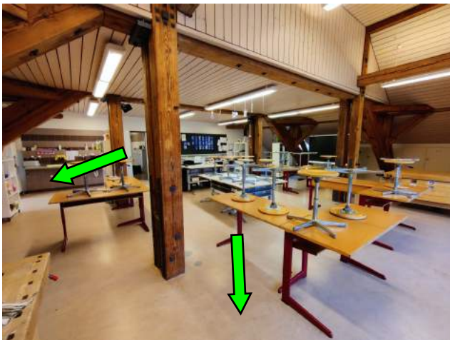
DG, Zimmer West Wandfliesen braun baugleich PK1, kein Asbest Bodenbelag beige baugleich BB1, kein Asbest Deckenabdeckung aus Pavatex/Holz, kein Asbestverdacht
