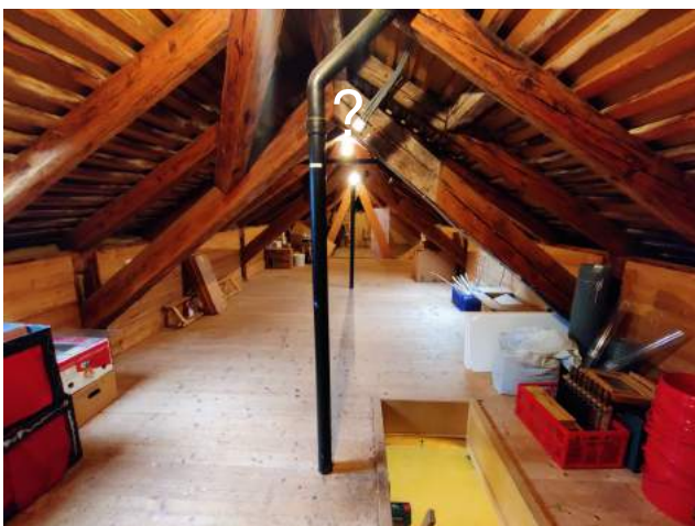
Estrich keine Bodenzwischenfüllung erkennbar, Wände mit Glaswollisolation, kein Asbestverdacht elektr. Anlagen/Lampen auf Holz: Asbestverdacht
