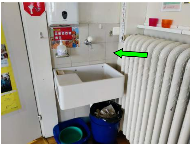
1.OG, Detail Lavabo PK3: Kleber Wandfliesen grau MP, kein Asbest
