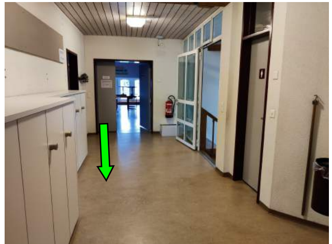
DG, Gang BB1: Bodenbelag beige, kein Asbest
