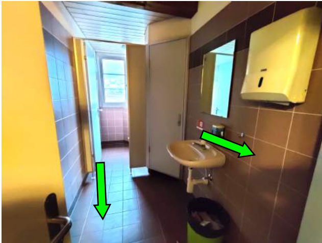
DG, beide WCs baugleich Wandfliesen braun baugleich PK1, kein Asbest PK2: Kleber Bodenfliesen braun, kein Asbest
