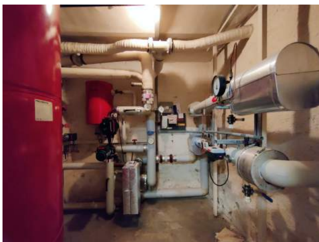
UG, Heizungsraum Heizung Jahrgang 1993/94: kein Asbestverdacht z.T. alte Leitungsisolationen aus Wolle, kein Asbestverdacht
