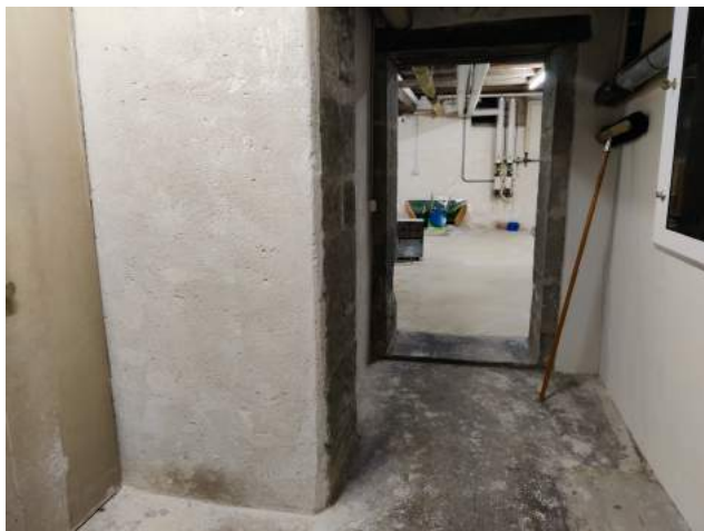
UG, Gang Wände, Decke und Boden aus unverputztem Beton, kein Asbestverdacht
