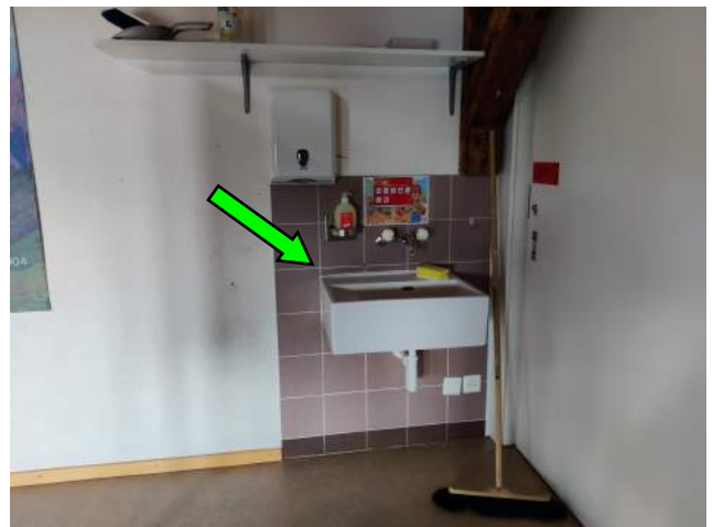
DG, Zimmer Ost, Detail Lavabo Wandfliesen braun baugleich PK1, kein Asbest
