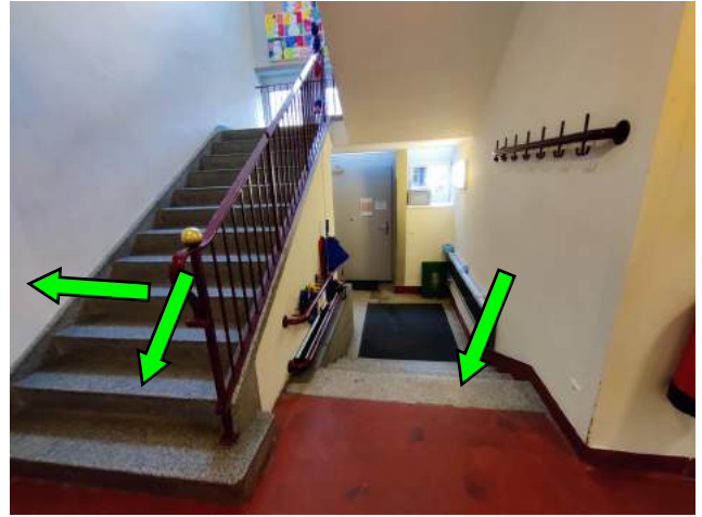
EG, Eingang Bodenfliesen Stein Eingang und Treppe in Zement verlegt (Nass-in-Nass), kein Asbestverdacht VP2: Innenverputz MP Treppenhaus,
