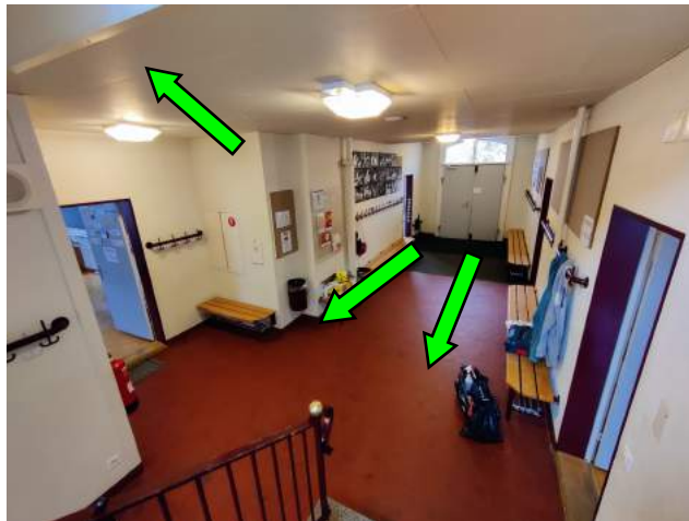
EG, Gang Boden- und Sockelfliesen Klinker rot in Zement verlegt (Nass-in-Nass), kein Asbestverdacht Iso1: Deckenplatten, kein Asbest
