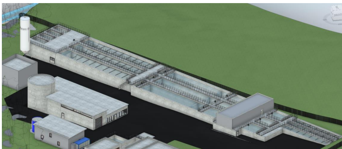
Figure 8 : Vue générale de la STEP et notamment des trois lignes de biologie et décantation
