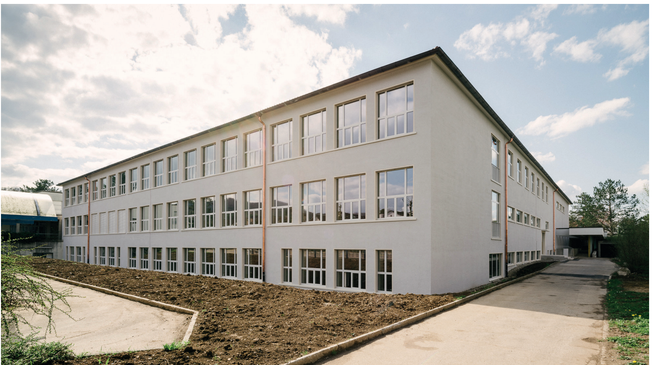
Trakt 2 Süd-Ost- und Nord-Ost Fassade
