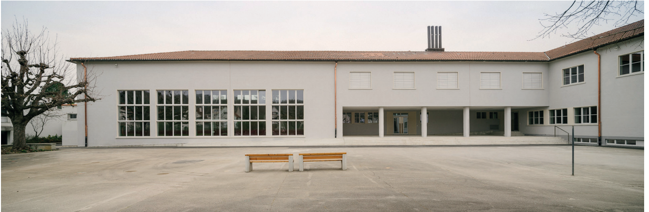
Trakt 2 Süd-West Fassade
