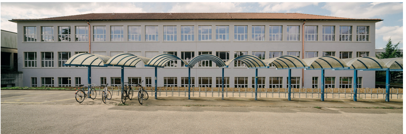
Trakt 2 Süd-Ost Fassade
