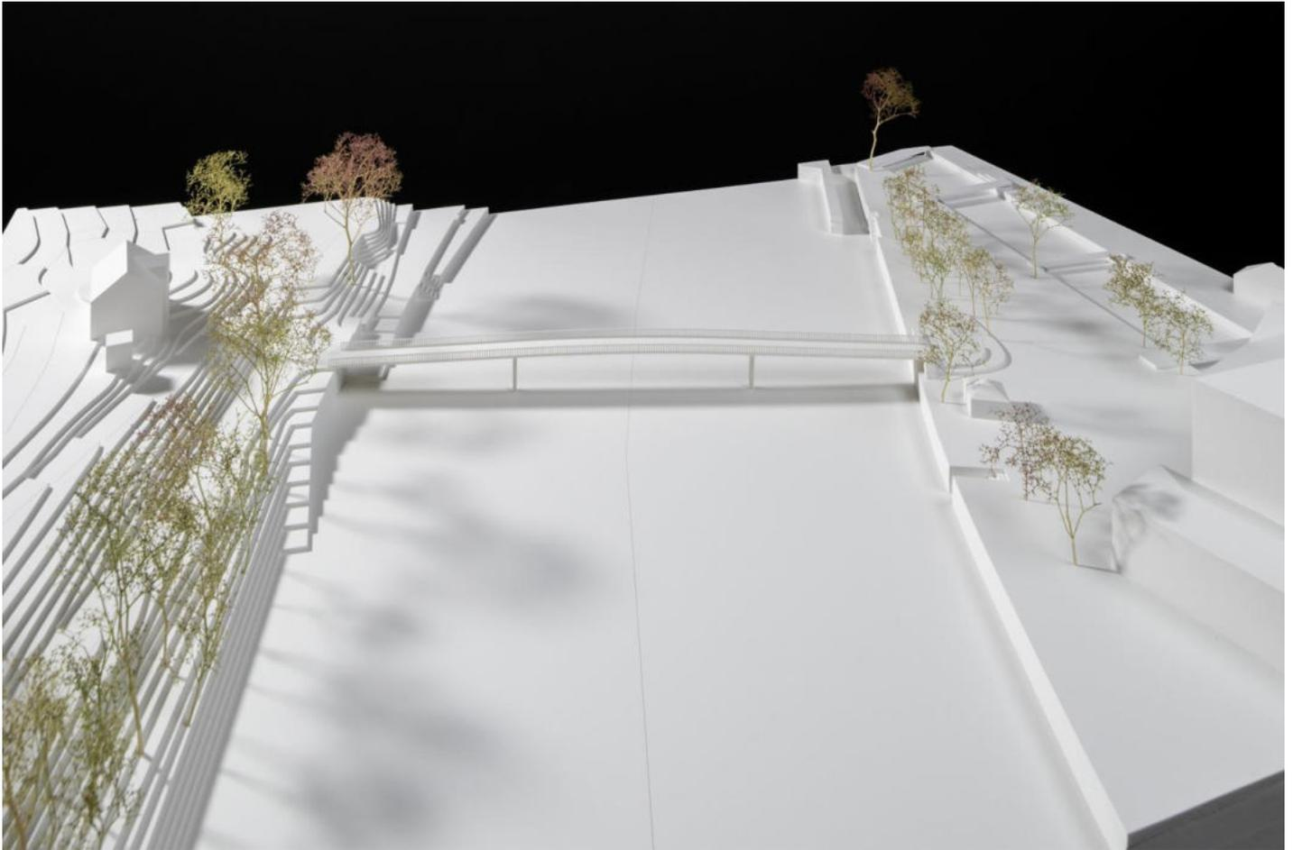
Stegen werden die Werkleitungen zugänglich integriert. Letztendlich beträgt die mittlere Dicke des Überbaus 0.57m und wirkt gemessen an der zugewiesenen Nutzung sehr schwer.
