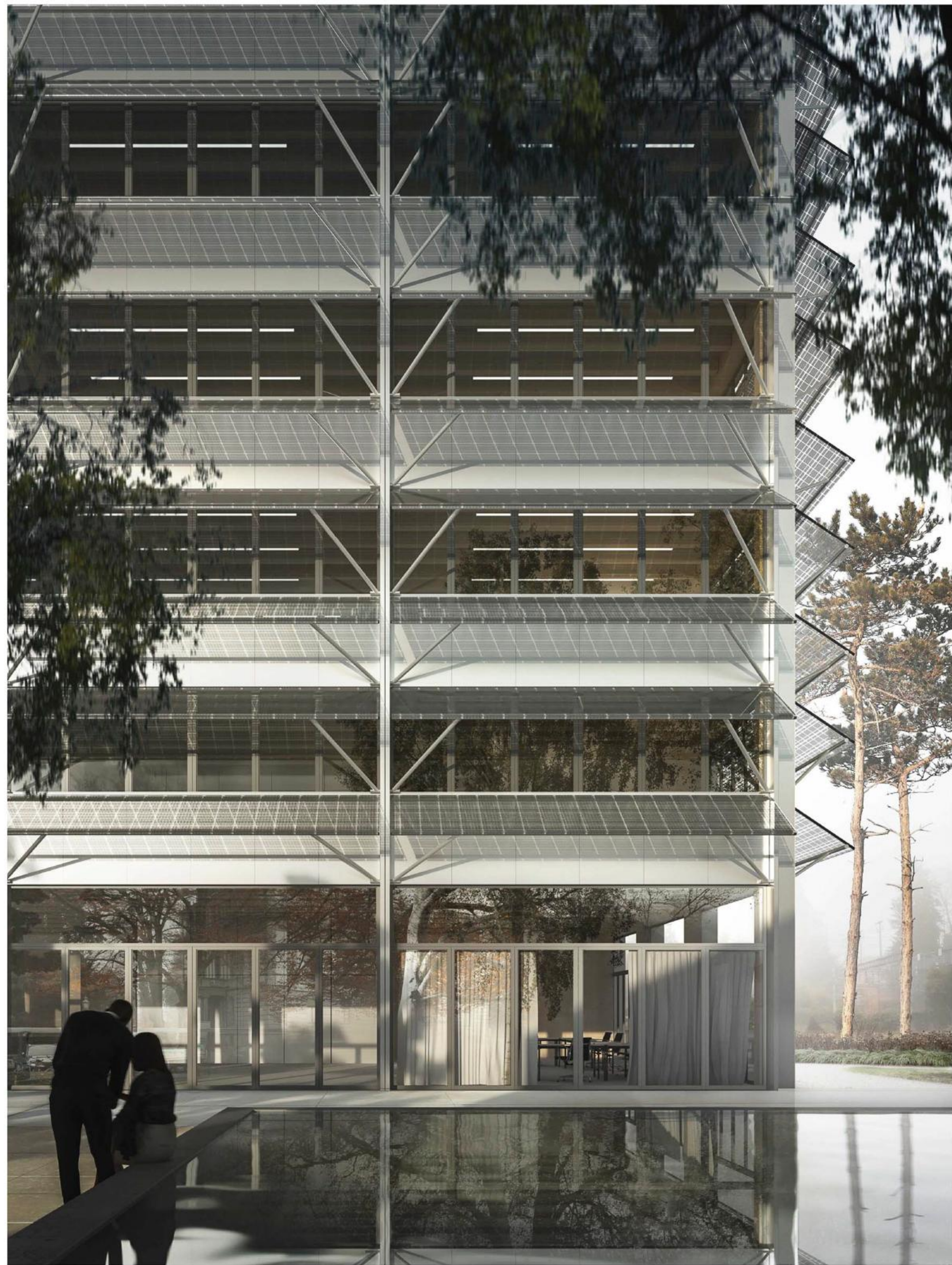
Die Gebäudehülle ist mehr als die Grenze zwischen innen und aussen. Energie wird aktiv über die Brise Soleil gewonnen. Gleichzeitig dienen diese als passiver Sonnenschutz. Das Wasserbecken dämmt den Hitzeineffekt durch Abkühlung der Umgebungsluft ein.
