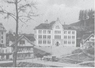
Schulhaus St. Georgen
