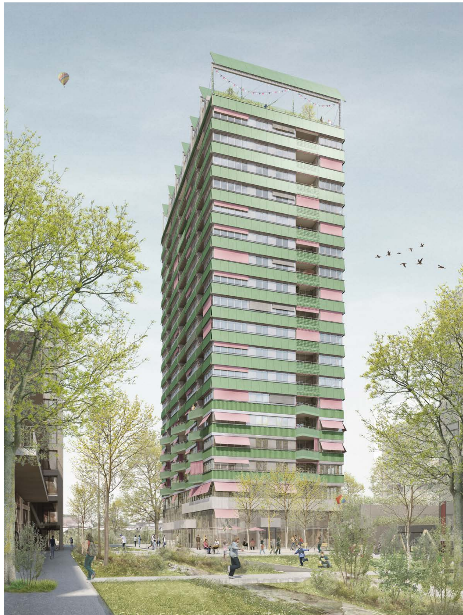
Die regelmässige, horizontale Fassadengliederung aus Fensterbändern und Brüstungsbänder mit schrägen Photovoltaikerelementen schafft eine gelassene und zeitlose, jedoch gleichzeitig prägende Gestalt.
