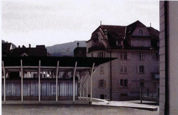
HERBST & WINTER Während den kalten Monate wird eine leichte Konstruktion mit Paneelen zur Isolation in die Rahmen eingefügt. Sie müssen keine Schneelast tragen da dies schon das darüber liegende Dach tut.
