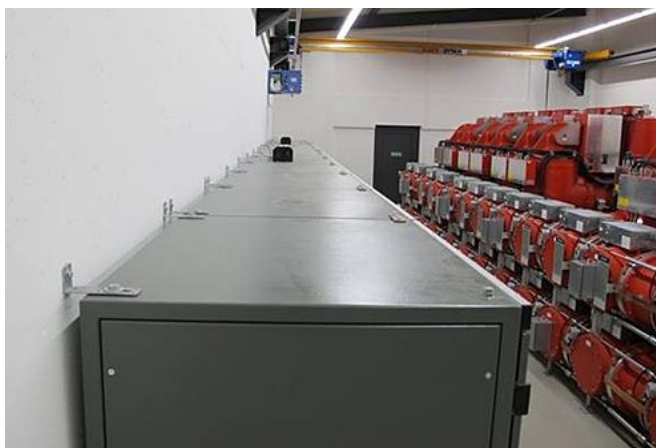
Abb. 2.13.6 und 2.13.7 > Sicherung von Schränken an der Wand
