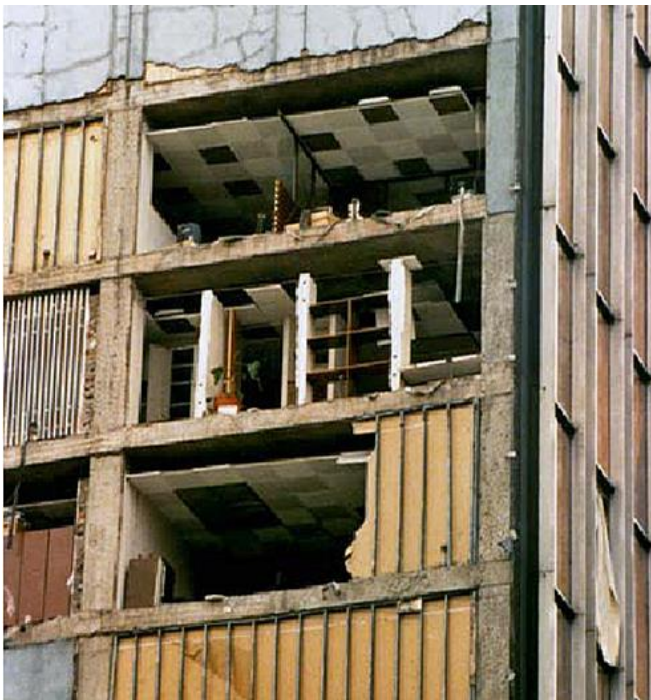
Abb. 2.5.3 > Versagen aus der Ebene einer vorgehängten Fassade
