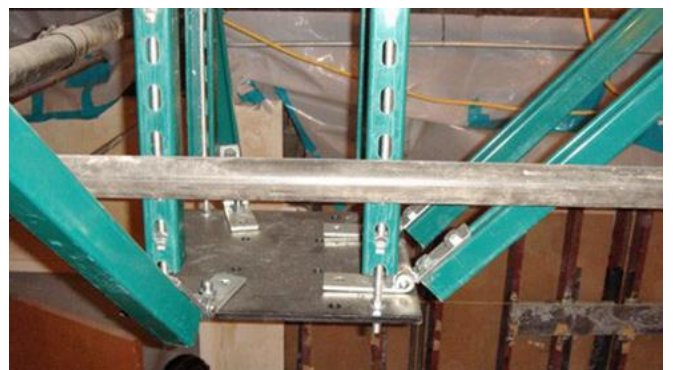
Abb. 2.15.4 > Aussteifung schwerer Leuchtkörper
