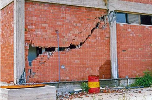
Abb. 2.4.1 > Druckdiagonale durch Mauerwerkswand und Schädigung der Stahlbetonstützen
