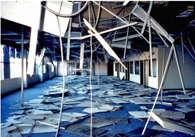
Abb. 2.2.1 bis 2.2.4 > Schäden an Deckenbekleidungen
