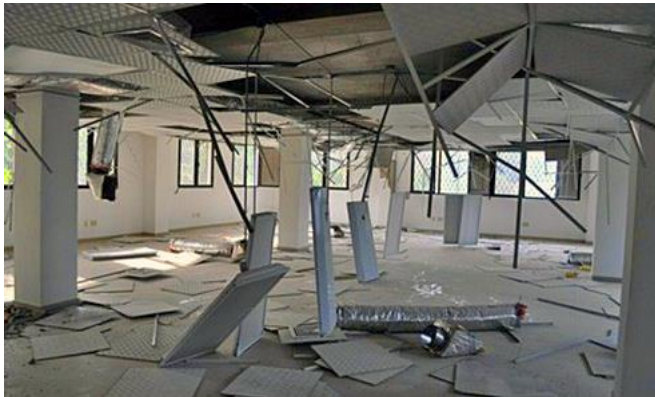
Abb. 2.15.1 und 2.15.2 > Absturz von Beleuchtungselementen
