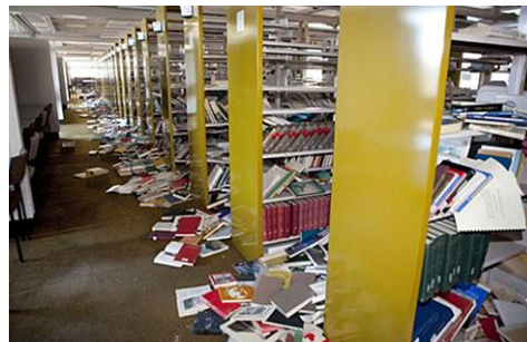
Abb. 2.22.5 und 2.22.6 > Kippen mehrerer Regalreihen infolge des Domino-Effekts
