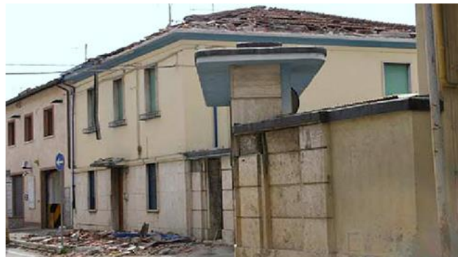
Abb. 2.10.2 > Heruntergefallene Dachziegel
