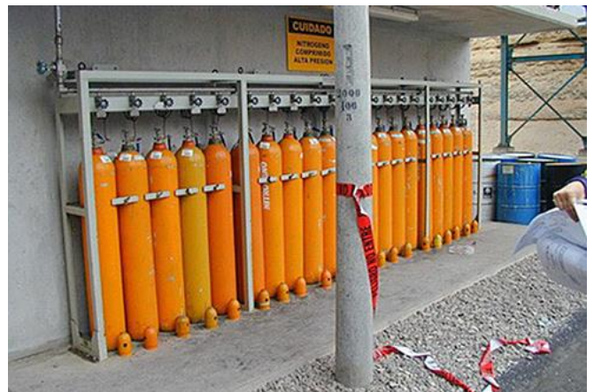
Abb. 2.17.8 > Befestigung von Zylinderflaschen
