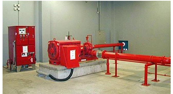
Abb. 2.12.4 &gt; Verankerung der Pumpe und Steuereinheit, flexible Leitungsverbindungen und Wanddurchbruch mit Spielraum
