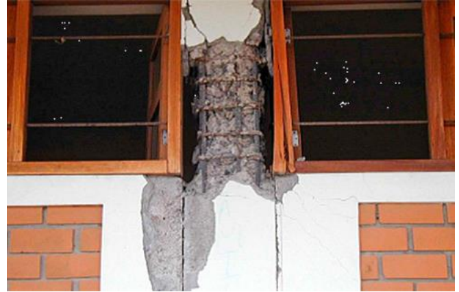
Abb. 2.4.2 > Schubbruch in kurzer Stütze bei Mauerwerksausfachung
