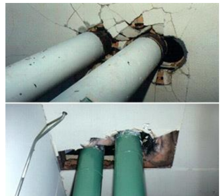
Abb. 2.18.6/2.18.7 > Schaden bei Wanddurchbrüchen
