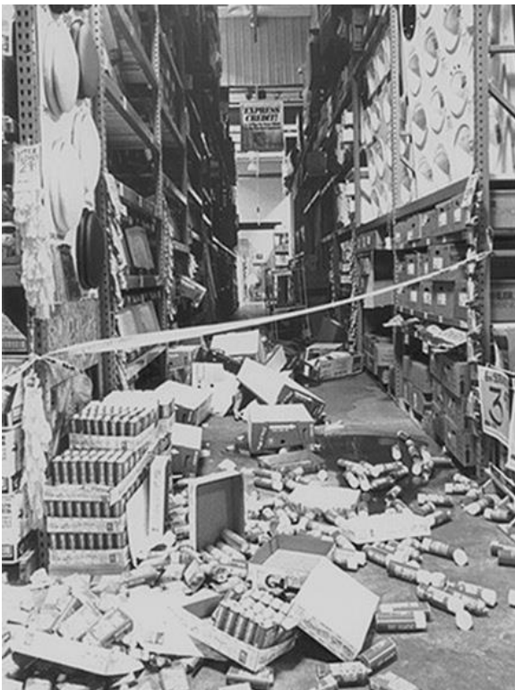
Abb. 2.23.4 und 2.23.5 > Beschädigtes Regal und herausgefallene Güter
