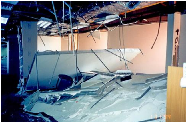
Abb. 2.4.3 und 2.4.4 > Schäden an Leichtbauwänden
