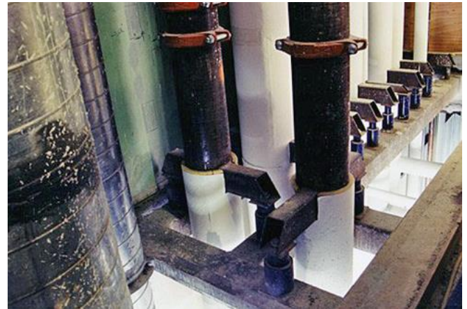
Abb. 2.18.11 > Lagerung von Steigleitungen bei Deckendurchbrüchen
