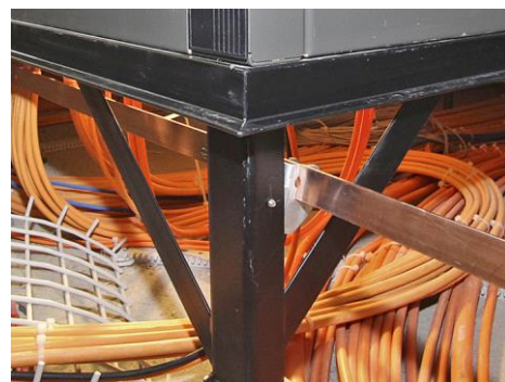
Abb. 2.3.8 > Horizontale Stabilisierung durch Diagonalstreben
