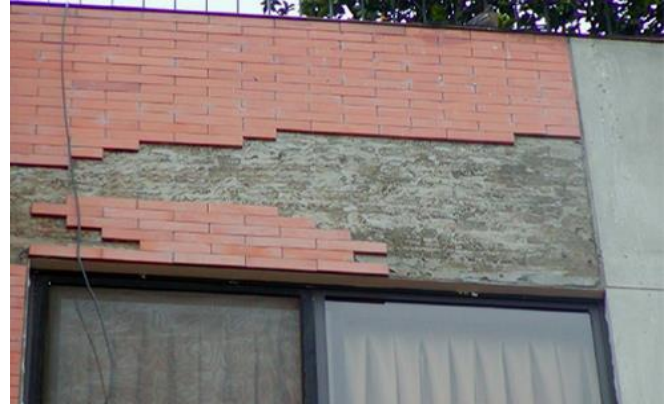
Abb. 2.5.2 > Ablösung von geklebten Elementen
