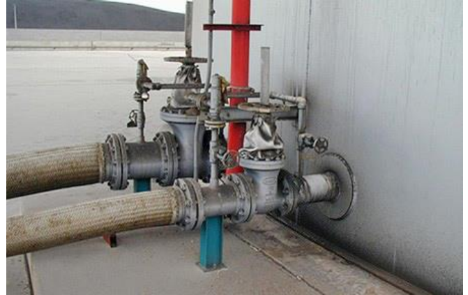
Abb. 2.17.6 > Flexibler Leitungsanschluss
