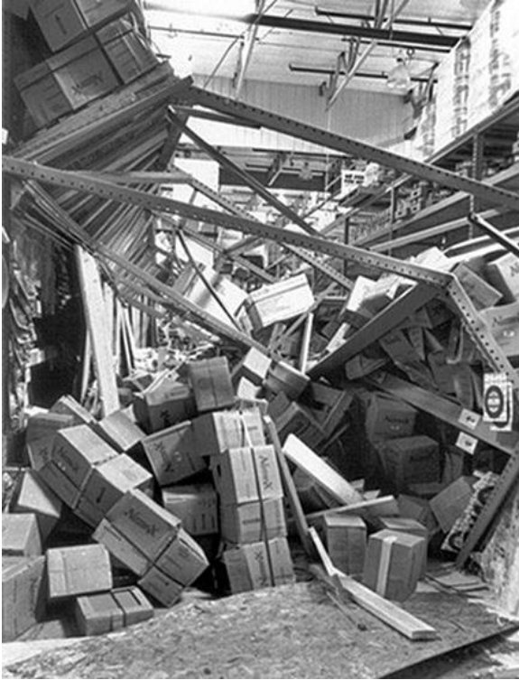
Abb. 2.23.1, 2.23.2 und 2.23.3 > Eingestürzte Hochregallager
