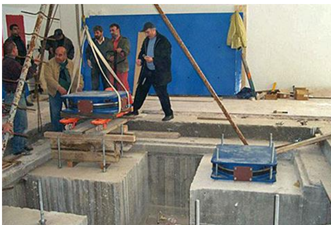
Abb. 2.25.6 und 2.25.7 > Schwingungsisoliertes Fundament für eine Skulptur
