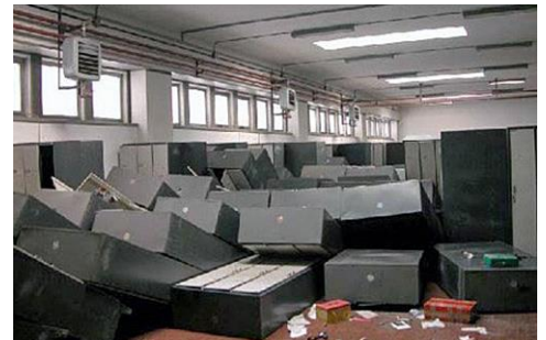
Abb. 2.22.5 und 2.22.6 > Kippen mehrerer Regalreihen infolge des Domino-Effekts
