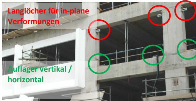
Abb. 2.5.5 > Befestigung von Fassadenelementen mit Langlöchern
