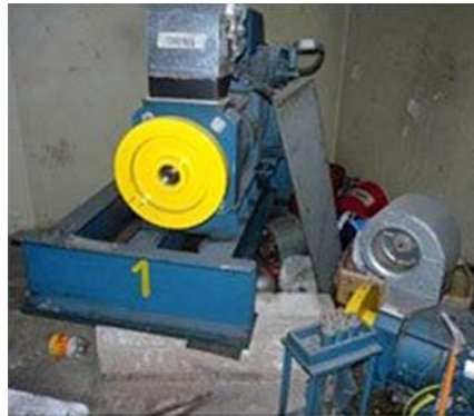
Abb. 2.19.2 > Ungenügend befestigte Antriebseinheit
