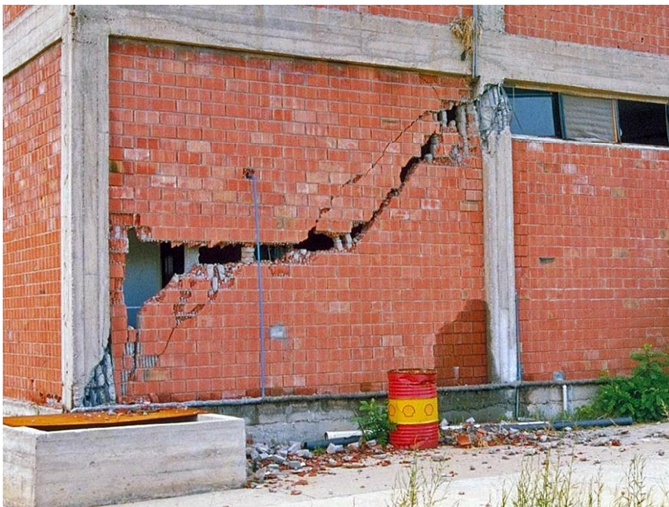
Abb. 1.4 > Schäden an Stützen durch Mauerwerksausfachung, Türkei Erdbeben 1998
