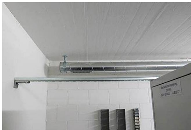
Abb. 2.13.5 > Verankerung von freistehenden Schrankeinheiten
