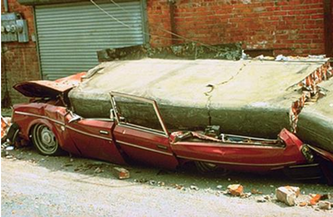
Abb. 2.6.1 und 2.6.2 &gt; Versagen infolge Trägheitskräften quer zur Brüstungsebene
