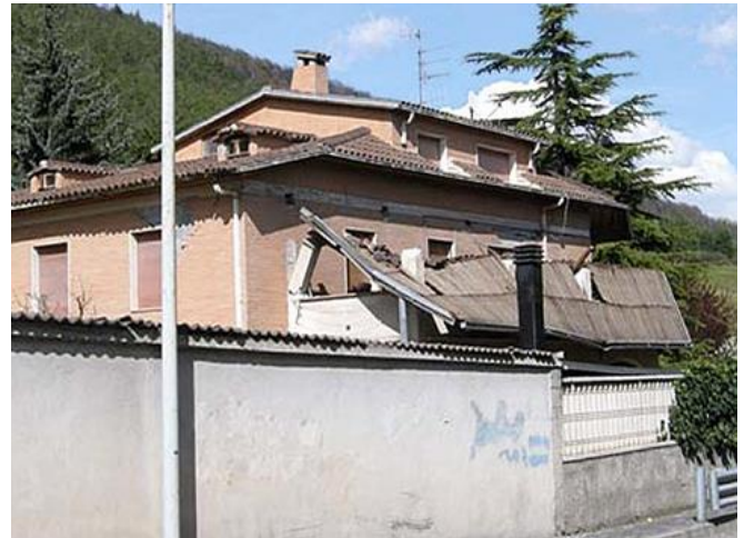
Abb. 2.9.2 &gt; Eingestürztes Vordach
