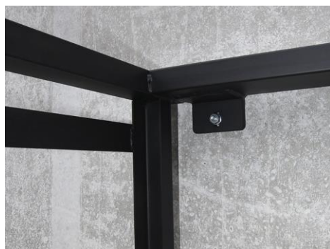
Abb. 2.3.7 > Befestigung Grundrahmen an Wand
