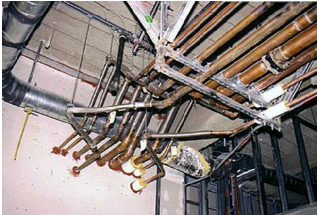
Abb. 2.18.10 > Flexible Verbindungen bei Wanddurchbrüchen, Aussteifung von Leitungstrasse
