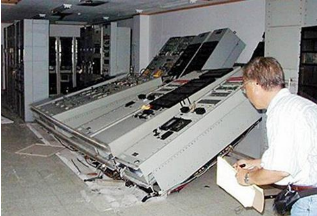
Abb. 2.13.1 und 2.13.2 > Umgekippte Steuerschränke
