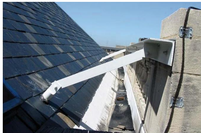
Abb. 2.6.6 > Massnahmen für Brüstungen auf dem Dach
