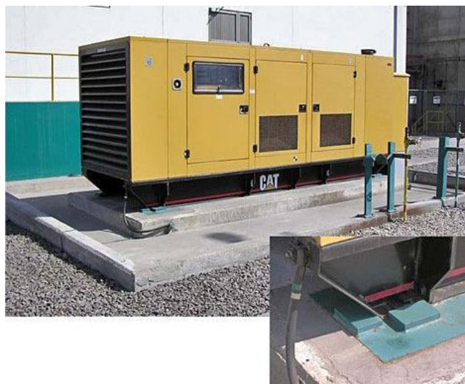
Abb. 2.16.7 > horizontaler Anschlag bei Generator
