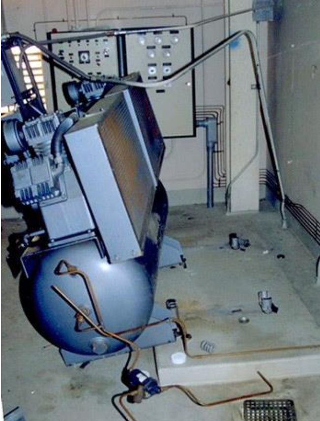
Abb. 2.20.1 > Versagen der Lagerung einer schwingungs isolierten Anlage
