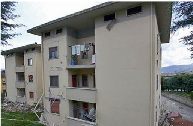
Abb. 2.6.3 &gt; Brüstung im oberen Geschoss herausgefallen
