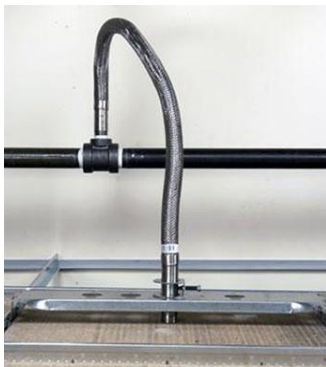
Abb. 2.12.3 &gt; Flexible Abzweigung von Hauptleitung
