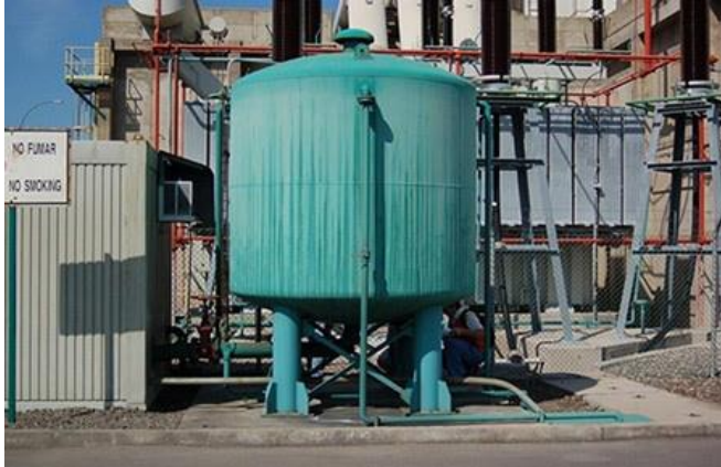
Abb. 2.17.5 > Aussteifung von aufgeständerten Tanks
