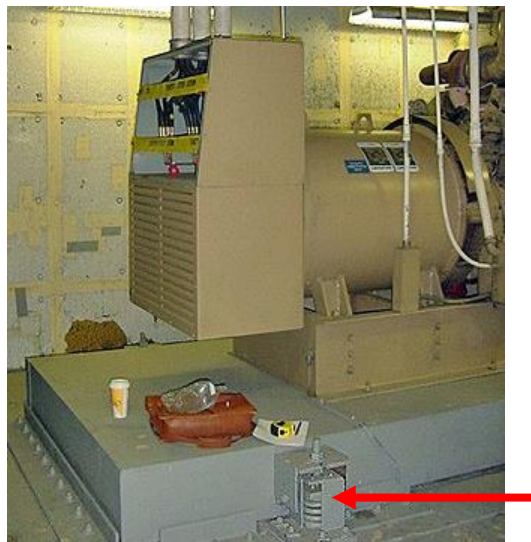
Abb. 2.20.5 > Feder mit vertikaler Sicherung, Puffer zur Begrenzung der Horizontalverschiebungen
