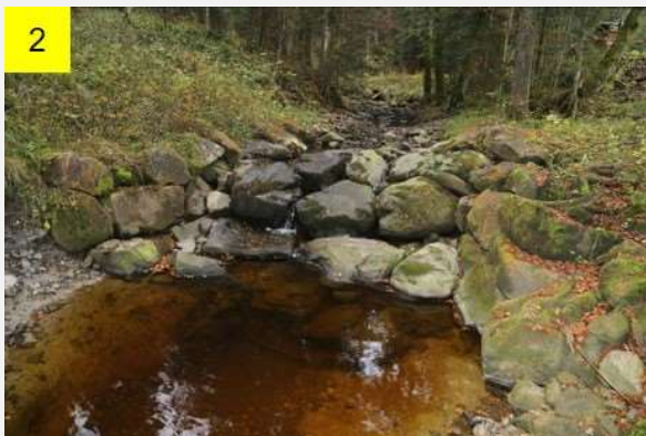
Kurze Blockrampe mit grossem Kolk (bis auf Felsuntergrund). Die untere Einbindung ist jedoch intakt und nicht unterspült (keine Unterkolkung).
