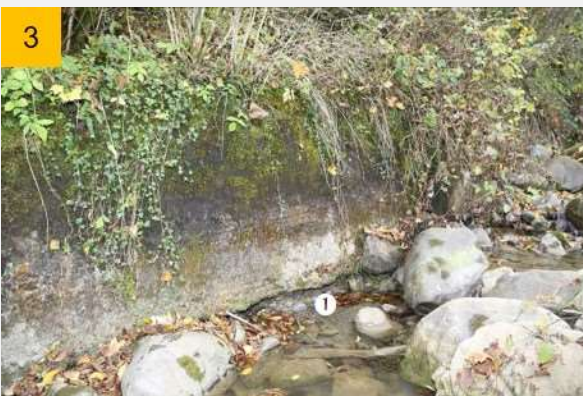
Längsverbau Beton. Nach einer Sohlenabsenkung wurde die untere Einbindung lokal unterspült ①.
