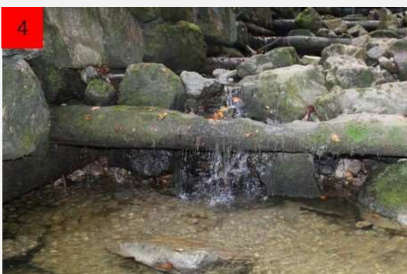
Holzschwelle, welche auf der ganzen Länge unterspült ist und frei liegt.
