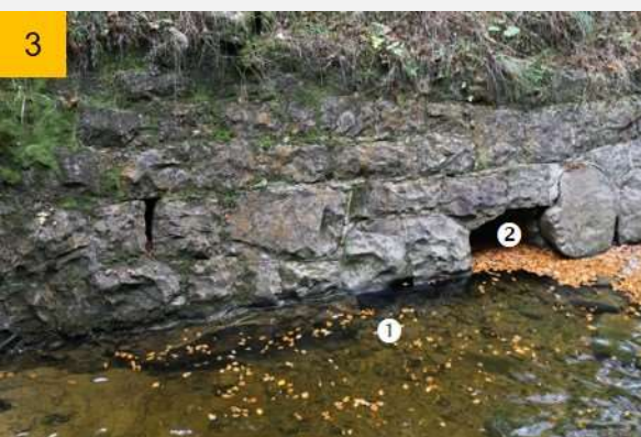
Längsverbau Stein mit lokaler Unterspülung ① und herausgefallenen Steinen aufgrund einer Sohlenabsenkung (②, wird als Schadensbild 19 Verwitterung/Abplatzung/... bewertet).
