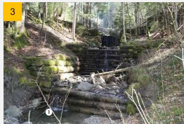
Holzsperrre mit Vorsperre. Die Vorsperre ist lokal unterspült ①.
