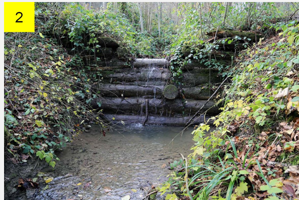
Holzsperrre mit grossem Kolk. Die untere Einbindung ist jedoch intakt und nicht unterspült (keine Unterkolkung).
