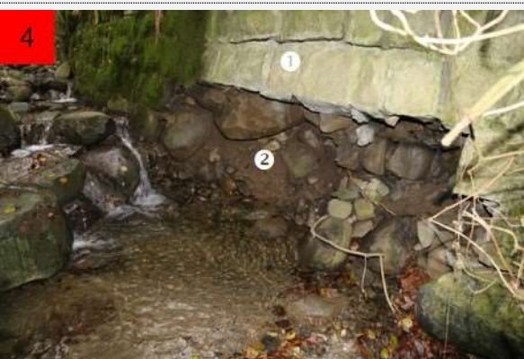
Längsverbau Stein mit Unterspülung. Deutlich sichtbar auch die sekundären Beeinträchtigungen 20 Verformung/Riss/Setzung/Bruch ① und 16 Erosion/Abrasion/Abtrag ②.
