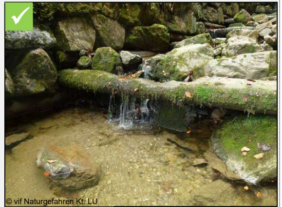
Abrasion der Holzschwelle gut sichtbar
