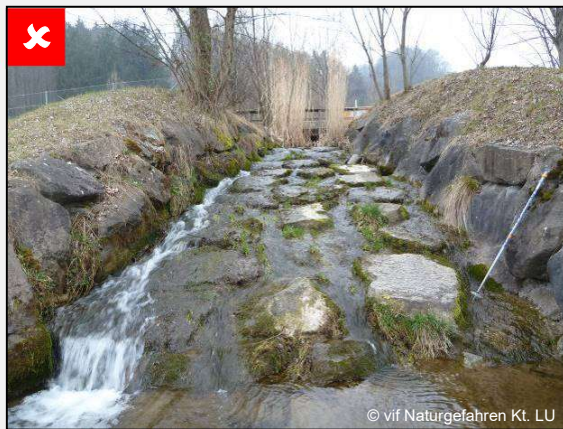
Foto an sich sehr gut, bei SBW mit Bauwerksparameter «Breite» den Stock als Referenz für die Breite quer zum Gerinne hinlegen
