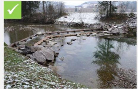
V-Schwelle als Doppelschwelle mit Steinen verstärkt.
