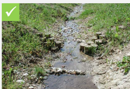
Die Pfahl Palisadenschwelle besteht aus senkrecht gerammten Pfahlreihen.
