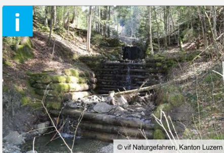
Hinweis: eine Vorsperre/-schwelle ist deutlich weniger hoch als die dazu gehörige Hauptsperre (hier mit Steinen verstärkt), ist baulich eng zusammenhängend und dient als Kolkschutz.
