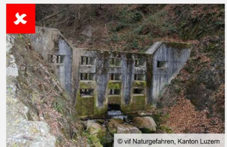
Abgrenzung: Balkensperren sind immer offen, dienen dem Geschieberückhalt und sollten daher nicht hinterfüllt sein.
