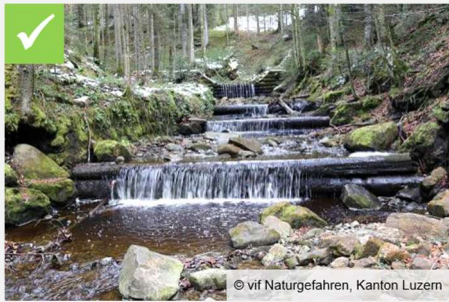
Einfache Rundholzschwelle mit eingebundenen Querhölzern.
