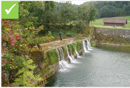
Die Einzelsperre mit vollkommenem Überfall.
