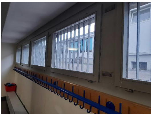
Abbildung 14: Fenster der Garderoben mit 2-fach-Verglasung.
