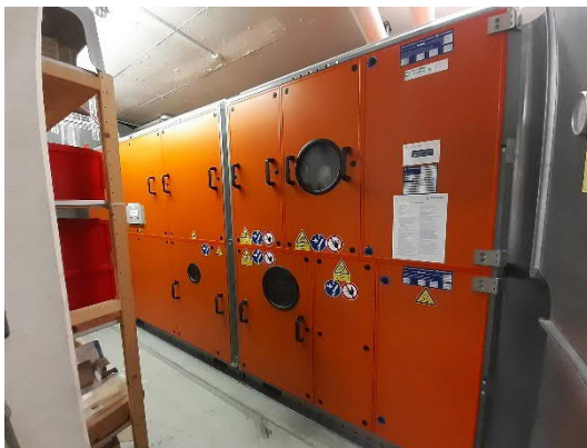
Abbildung 6: Lüftungsgerät der Schwimmhalle mit Wärmerückgewinnung und Wärmepumpe.
