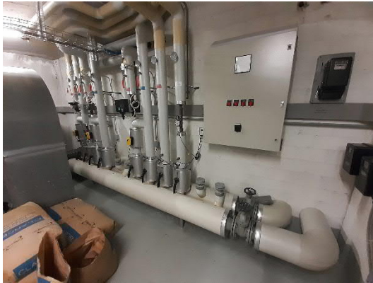
Abbildung 8: Heizverteiler im EG.
