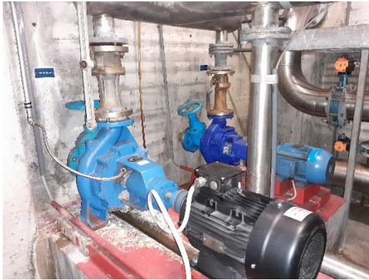
Abbildung 4: Filterpumpen mit unterschiedlichem Alter und ohne Drehzahlregelung
