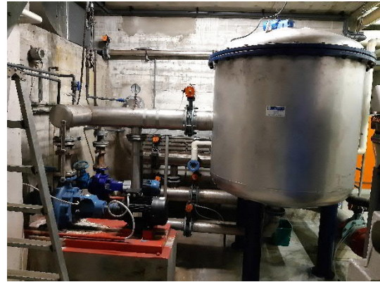
Abbildung 5: Anschwemmfilter der Badewasseraufbereitung.
