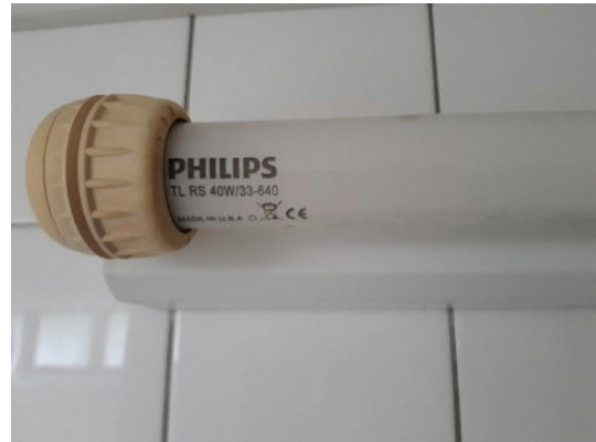
Abbildung 12: Leuchtstoffröhren in den Duschen und Garderoben.
