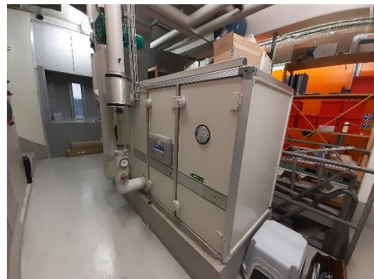
Abbildung 7: Zuluftgerät der Garderobenlüftung.
