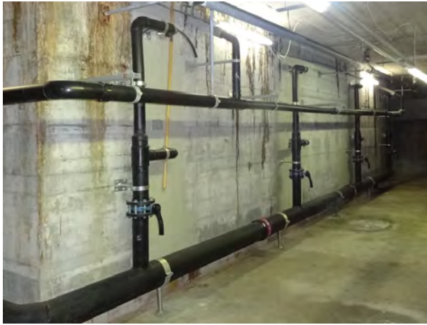
Stirnseite des Beckens mit Reinwasser-Leitung PE (unten) zu den Einlaufdüsen und Rinnenrücklaufleitung PE (oben)
