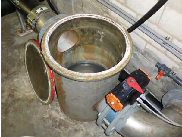
Vorfilterbehälter mit leichter Korrosion
