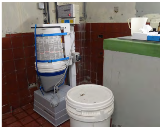
Granulat-Dosieranlage
