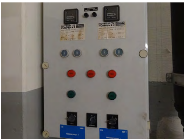
Steuerung Abwasserpumpen
