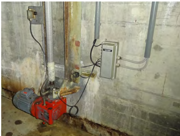
Spindelantrieb Hubboden
