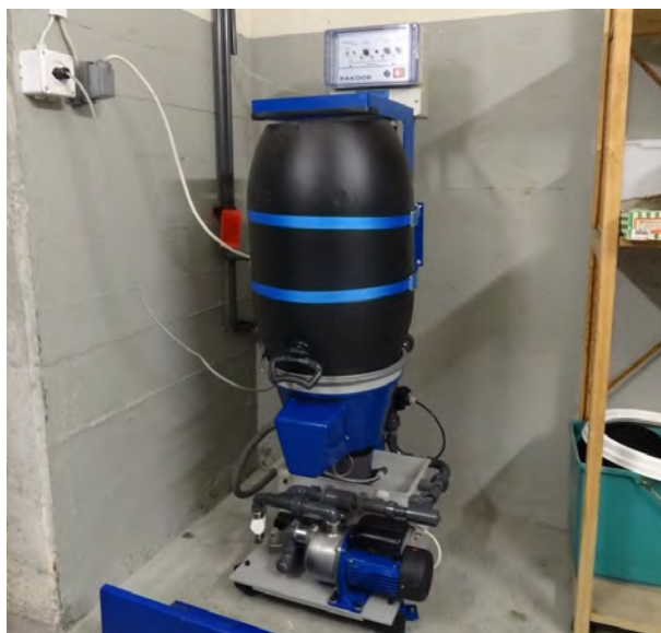
Dosieranlage für Pulver-Aktivkohle
