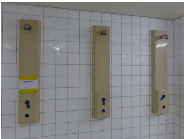
defekte Duschpanele
