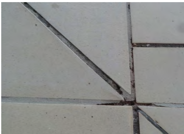
ausgeschwemmte Plattenfugen in Beckenumgängen
