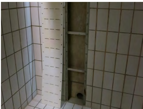
Beckeneinströmung an der Stirnseite des Beckens
