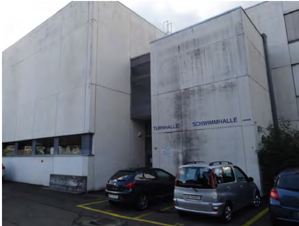
Verfärbungen an der Betonfassade durch feuchte Abluft aus der Lüftungsanlage
