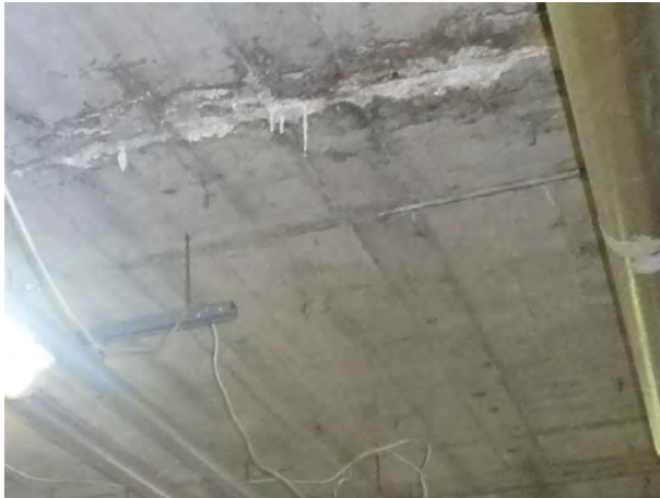
Spuren von wiederholtem Wasseraustritt im Untergeschoss
