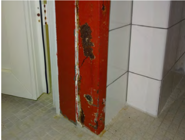
verrostete Türzarge mit aufgedoppelter Türe in Kunststoff
