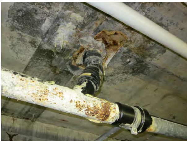
undichter Ablauf vom Beckenumgang
