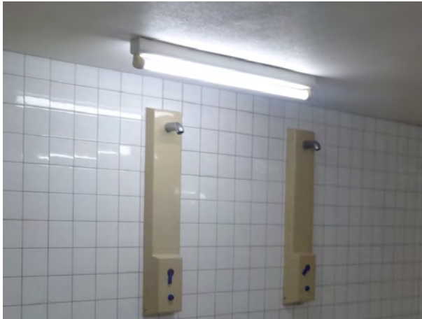
aufputz montierte Deckenbeleuchtung
