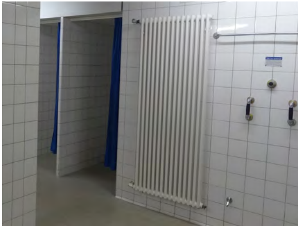
Röhrenradiatoren an der Wand
