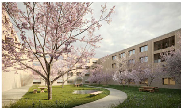
Vue de la cour intérieure du bâtiment
