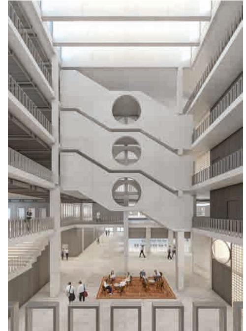
Das Eingangsfoyer besitzt auch eine klimatische Funktion: Wie ein Badger-Windturm flügel es den Kaltluftstrom vom Rosenberg auf und belüftet die Universität auf natürlicher Art und Weise. Nachts kann die Luft zur Auskühlung durch die Fenster entweichen.
