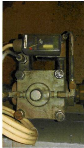
Magnetventil zu Zyklonfilter (defekt)
