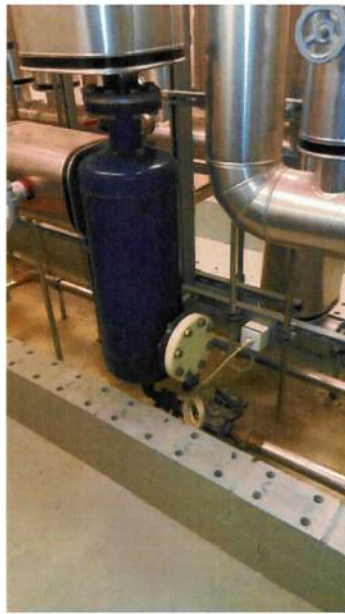
Zyklonfilter Kaltwasser
