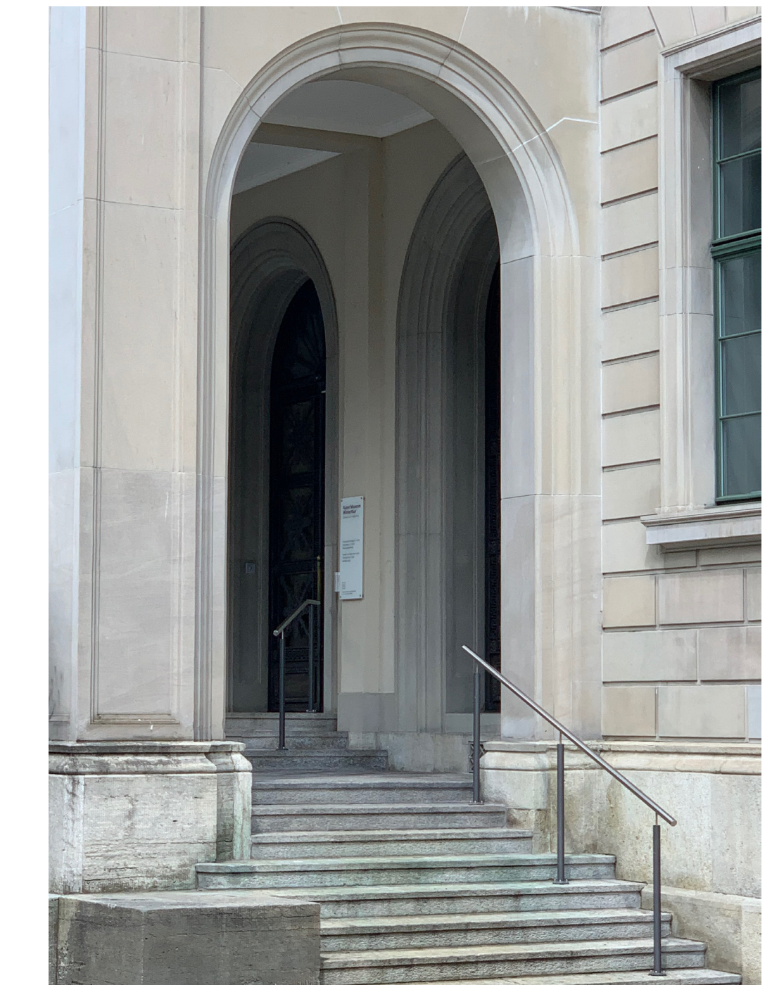
Heutige Situation Seitentreppe Portikus
