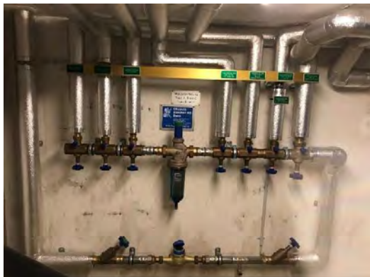
Abbildung 10: Wasserverteilung Trakt A; C; D
