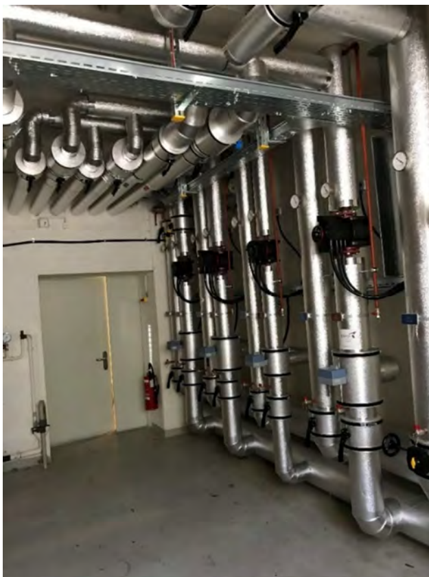
Abbildung 3: Wärmehauptverteilung
