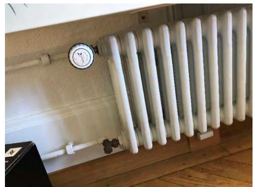
Abbildung 4: Wärmeabgabe mit Heizkörper und unisolierten Heizleitungen und Thermostatventil
