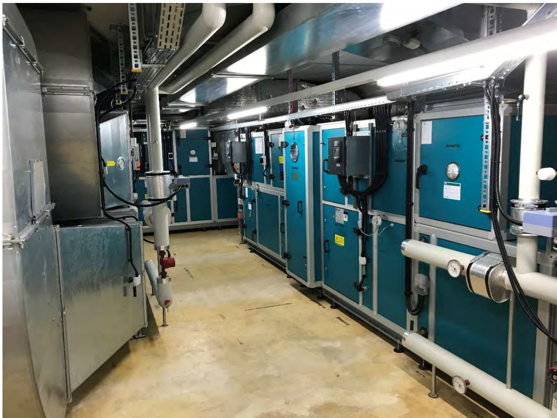
Abbildung 6: Lüftungsanlage Cafeteria und Küche
