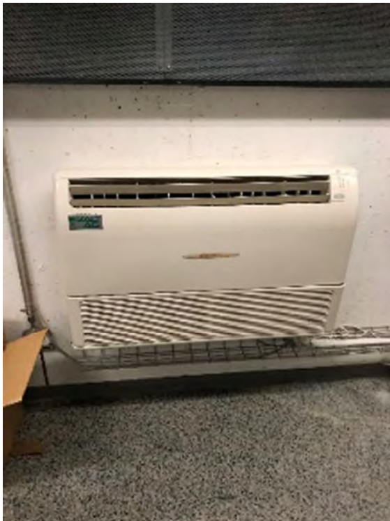
Abbildung 7: Splitgerät KOMBV-Raum
