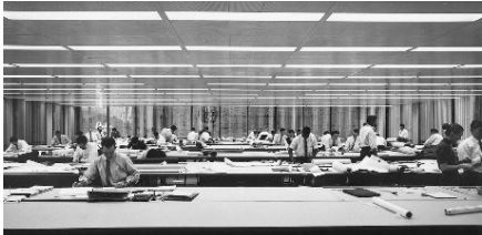
Flexibilität Offene, stützenfreie Flächen durch weit spannende Decken und aussenliegendes Tragwerk. SOM, Inland Steel Building, Chicago 1958
