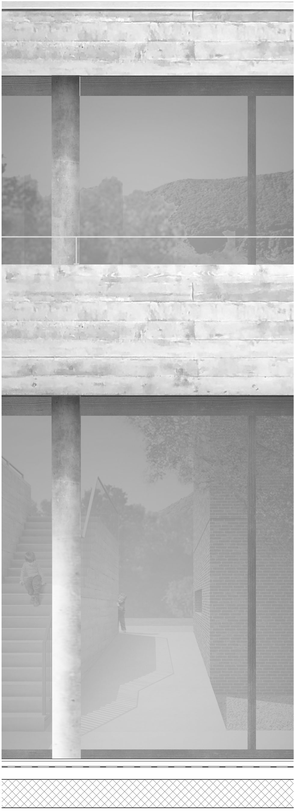
VISTA ESTERNA AMPLIAMENTO (CORTE)
