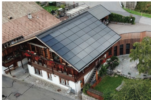
Fig. 3 Rénovation BEP 222% de la villa Grunder, Brienz (BE)
