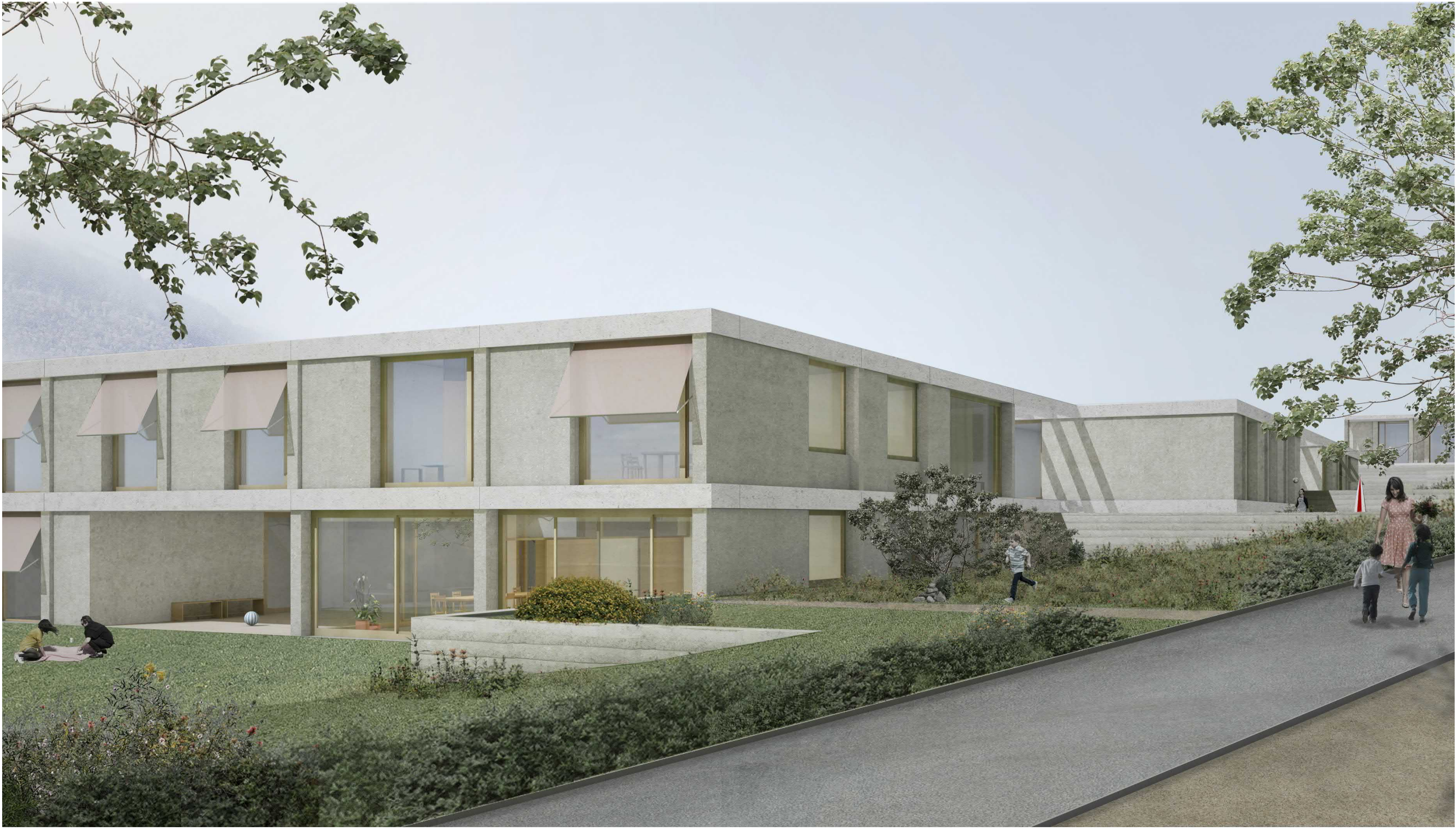
Sitzmauern aus Stampfbeton formen hangseitig eine terrassierte Landschaft, welche private Gartenhöfe schafft und den einzelnen Stationen einen ebenen Terrainanschluss ermöglicht
