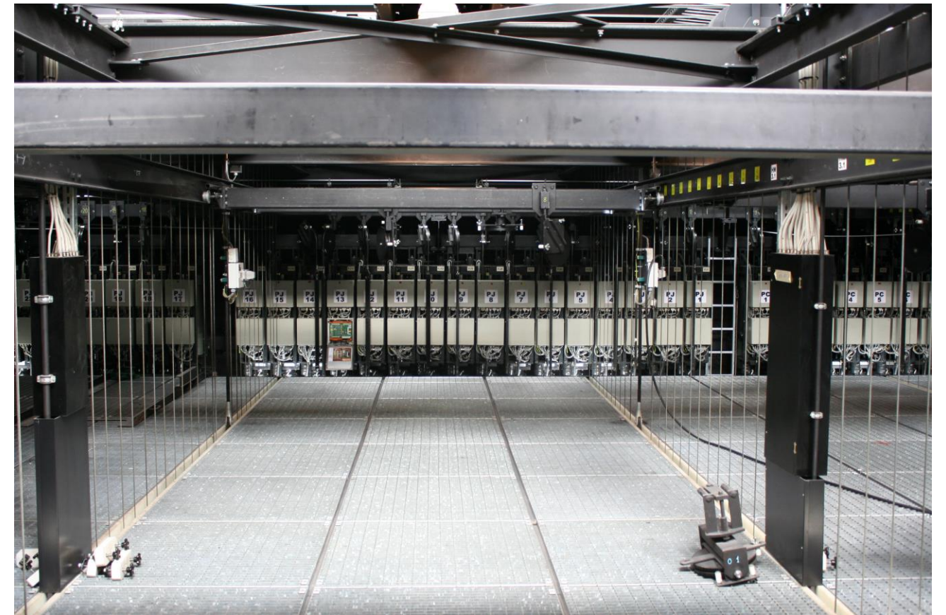
Les poulies de renvoi des ponctuels Die Umlenkrollen der Punktzüge
