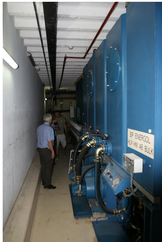
Pompes de la station de pression de la machinerie supérieure / Pumpen der Druckstation der Obermaschinerie
