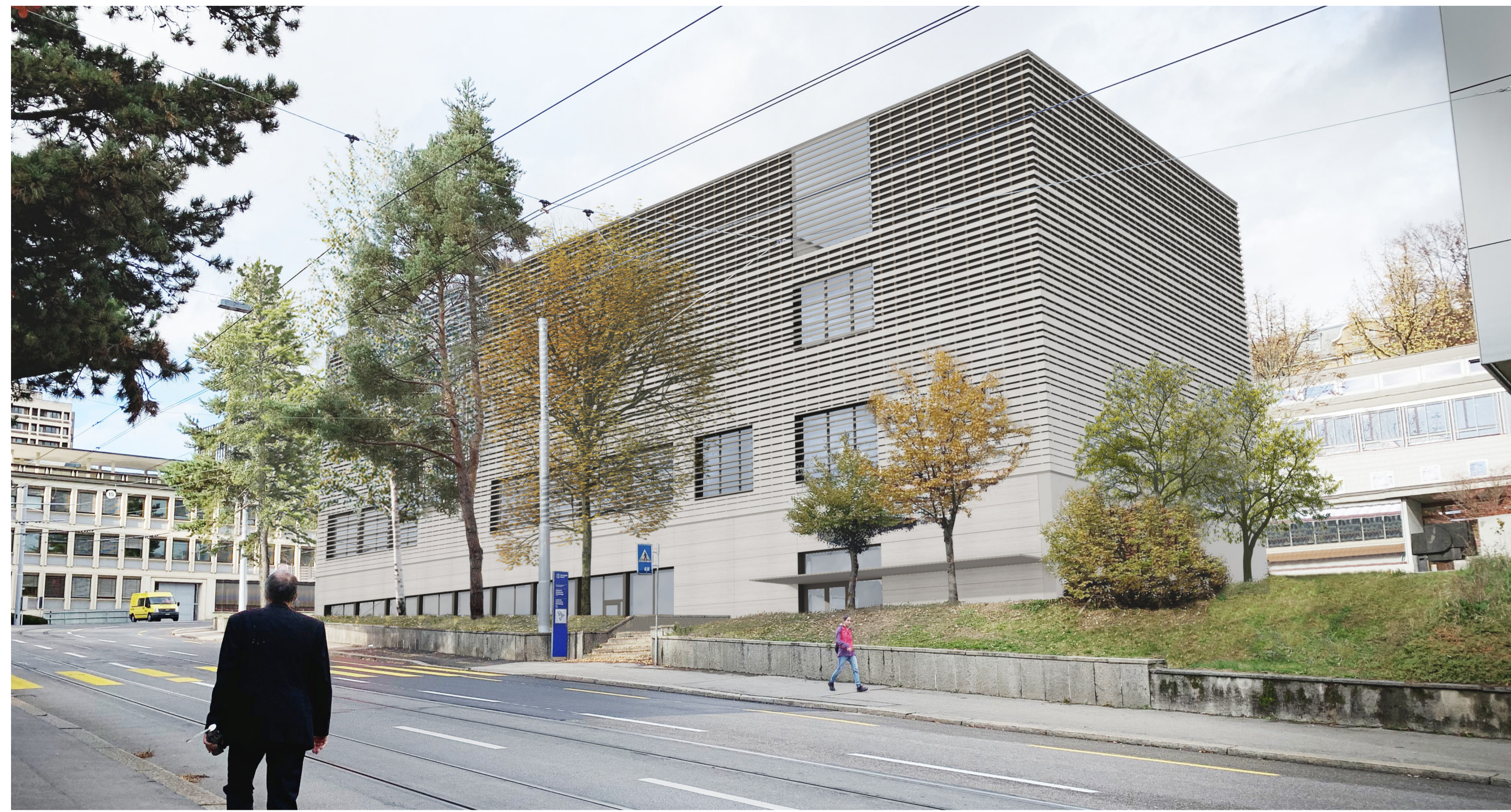
Neubau Sporthallenprovisorium Gloriarank - Branigan
