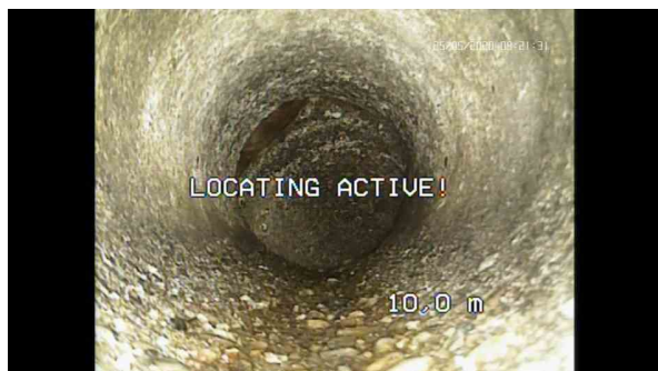
, 00:08:45, 10.00 Remarque générale / CANALISATION VETUSTE ET POREUSE
