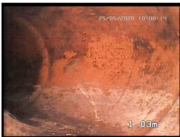
, 00:00:40, 1.03 Courbure vers la gauche, déviation en degrés: 45°
