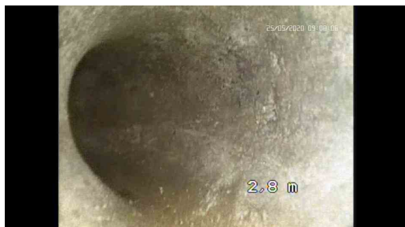
, 00:00:33, 2.80 Courbure vers la gauche, déviation en degrés: 45°
