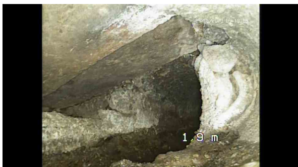
, 00:02:24, 1.90 Remarque générale / ARRIVEE SUR CANALISATION PRINCIPALE, PRESENCE D' UN REGARD DEPISTE A 0.50
