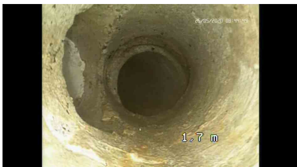
, 00:00:43, 1.70 Raccordement avec pièce préfabriquée, hauteur: 100mm, largeur: 100mm à 9 h. / GRILLE DE SOL
