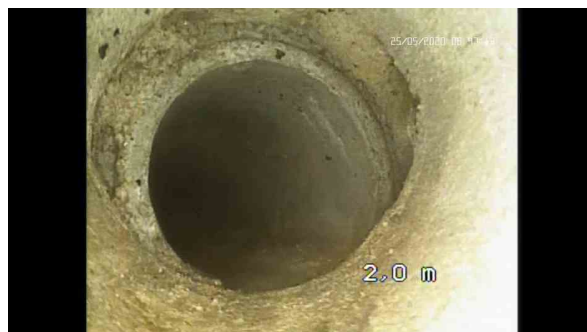
, 00:03:07, 2.00 Courbure vers la gauche, déviation en degrés: 45°
