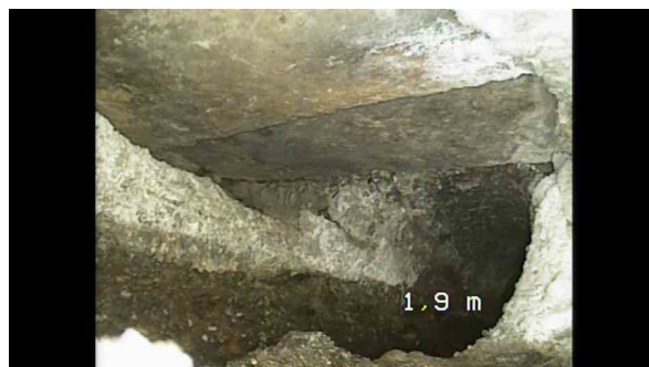
, 00:02:24, 1.90 Remarque générale / ARRIVEE SUR CANALISATION PRINCIPALE, PRESENCE D' UN REGARD DEPISTE A 0.50
