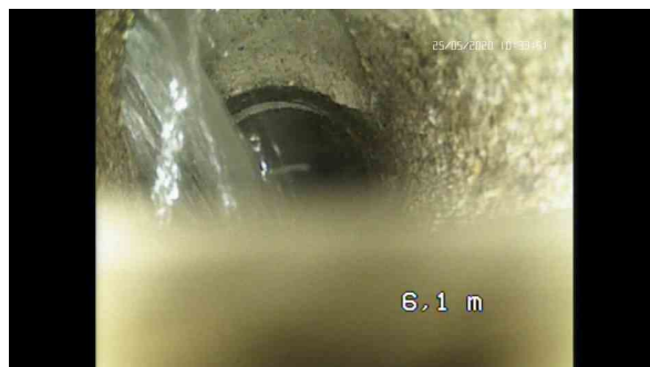
, 00:02:43, 6.10 Raccordement avec pièce préfabriquée, hauteur: 100mm, largeur: 100mm à 11 h. / FONTAINE
