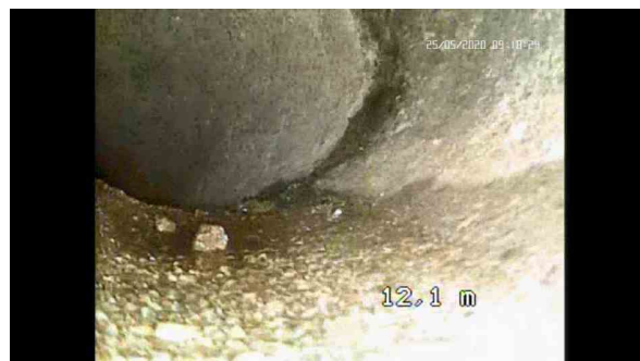
, 00:05:38, 12.10 Courbure vers la gauche, déviation en degrés: 45°
