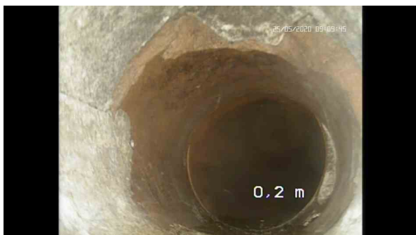
, 00:00:19, 0.20 Remarque générale / CHANGEMENT DE MATERIAU BETON A GRES
