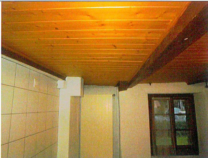
SOLIVAGE DANS PARTIE AMENAGEE Solives supportant le plancher Lambris entre solives
