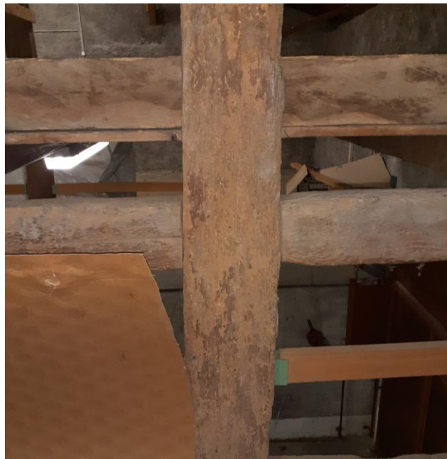
Figure 2 - Photo d'un pilier ayant subi des infiltrations
