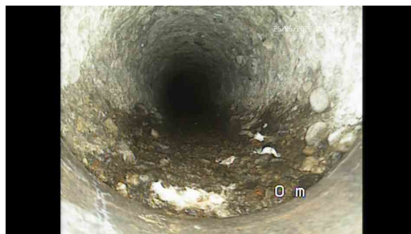
, 00:00:23, 0.00 Début de la canalisation / REGARD EU 2, CANALISATION POREUSE ET VETUSTE
