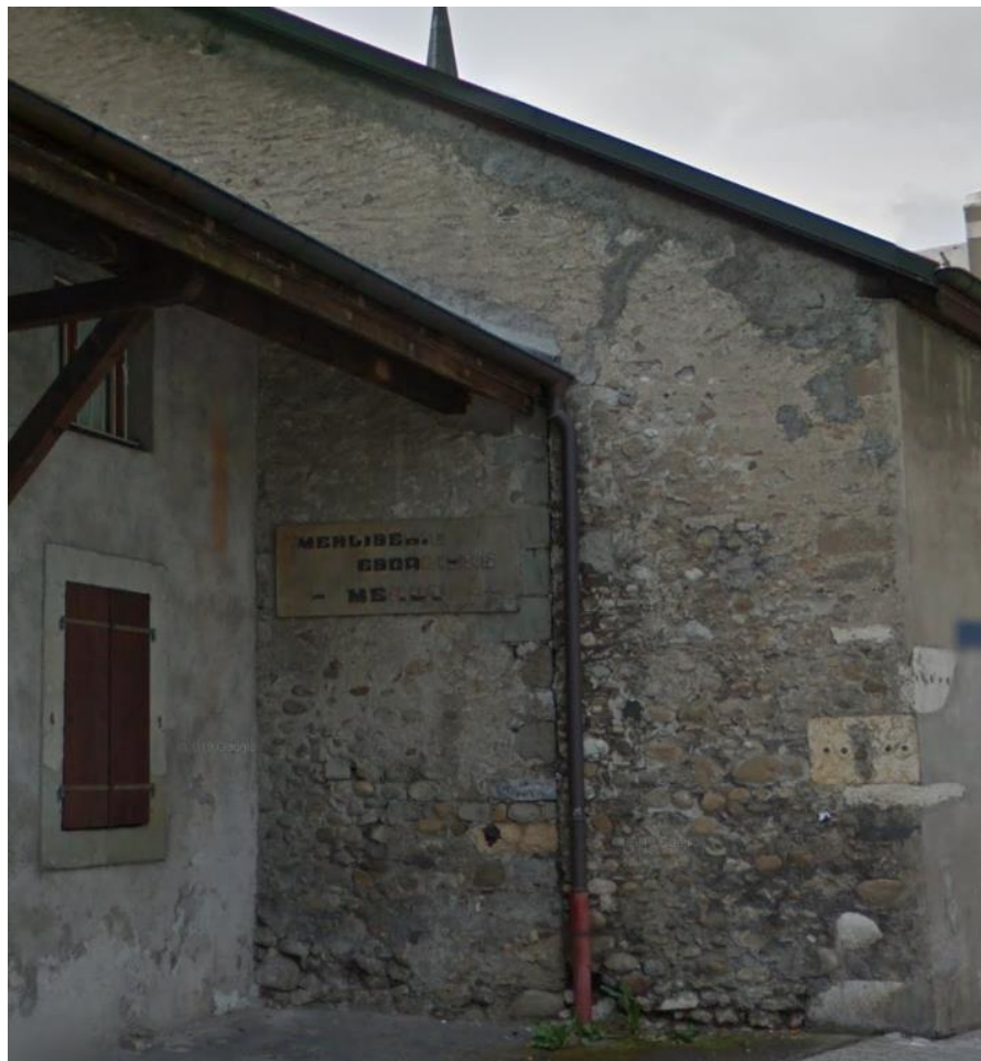
Figure 3 - Photo du pignon avec mur en moellon apparent
