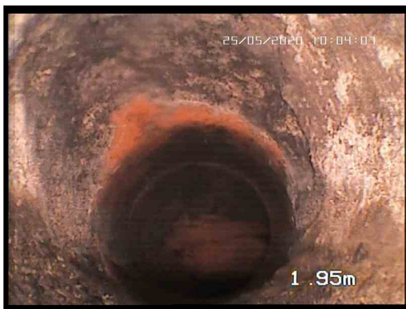
, 00:00:54, 1.96 Remarque générale / CHANGEMENT DE MATERIAU BETON A P.V.C
