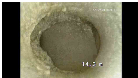
, 00:02:11, 14.20 Inspection abandonnée / COUDE 90° GAUCHE , CAMERA BLOQUEE
