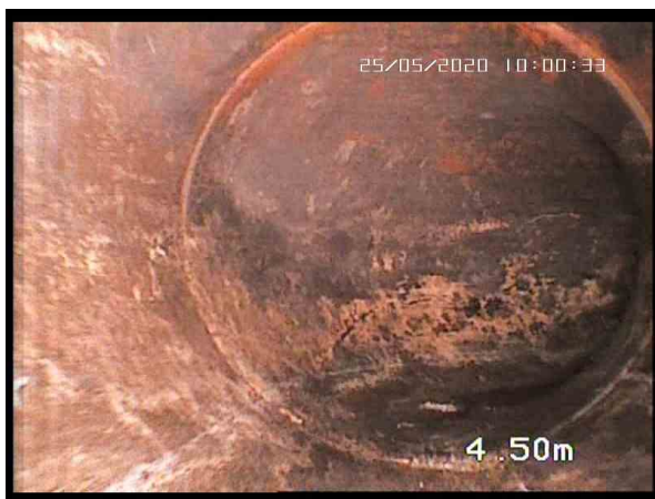
, 00:00:58, 4.50 Courbure vers la droite, déviation en degrés: 90°
