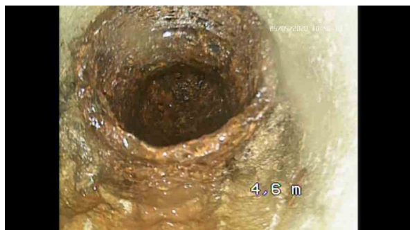
, 00:00:58, 4.60 Référence du noeud d'arrivée / PIED CANALISATION ( FONTE )
