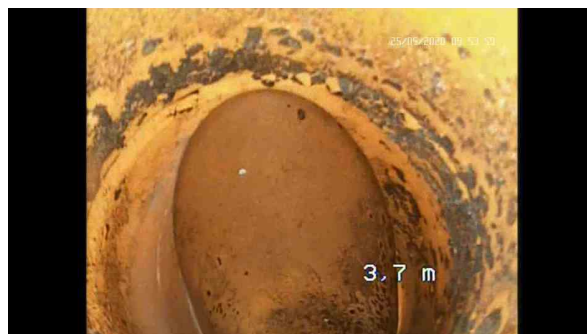
, 00:00:41, 3.70 Remarque générale / ARRIVEE SUR RACCORDEMENT LAVABO
