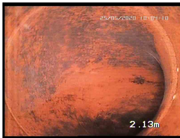
, 00:00:55, 2.13 Courbure vers la droite, déviation en degrés: 90°
