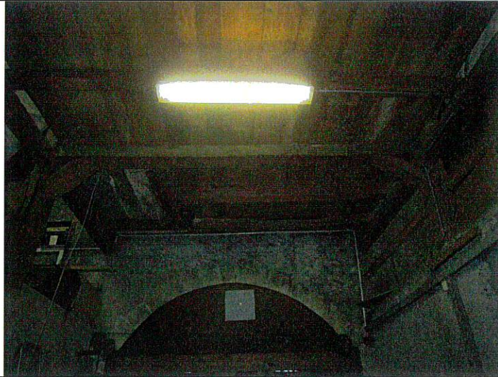
SOLIVAGE SUR PORTE DE GRANGE Sommiers avec bras de force Solives supportant le plancher
