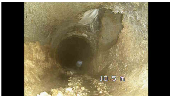
, 00:01:29, 10.50 Selle carottée, hauteur: 100mm, largeur: 100mm à 3 h. / RACCORDEMENT INCONNU
