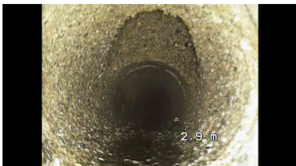
, 00:00:52, 2.90 Raccordement avec pièce préfabriquée, hauteur: 100mm, largeur: 100mm à 12 h. / SAC CANIVEAU INTERIEUR
