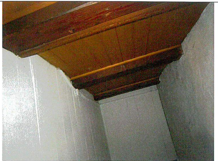
SOLIVAGE DANS PARTIE AMENAGEE Solives supportant le plancher Lambris entre solives
