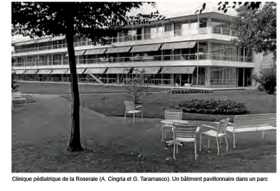
Clinique pédiatrique de la Roseira (A. Cirigli et G. Taramasco). Un bâtiment pavillonnaire dans un parc.
