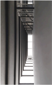
FLUIDITÄT UND TRANSPARENZ DURCH GROSSE SPANNWEITEN
