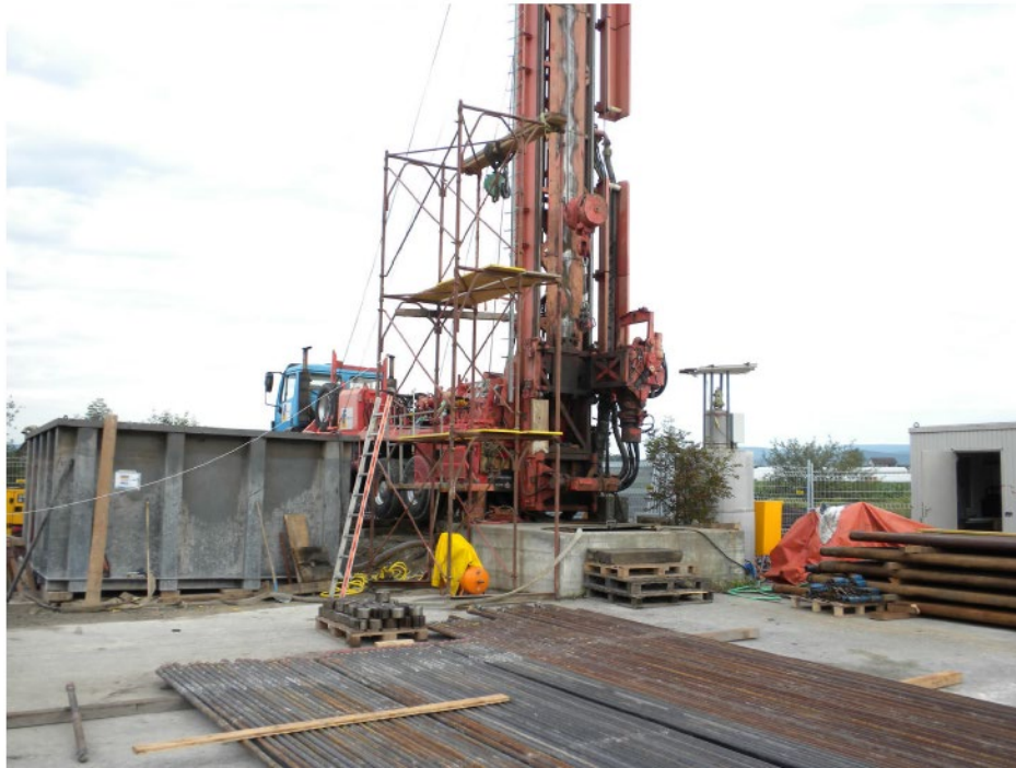
Figur 1: Tubinglager und Bohranlage mit Gerüst für Umlenkrollen
