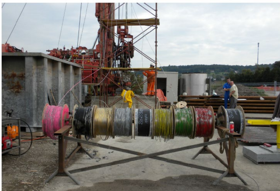
Figur 2: Abrollvorrichtung mit 1/4" Edelstahlleitung
