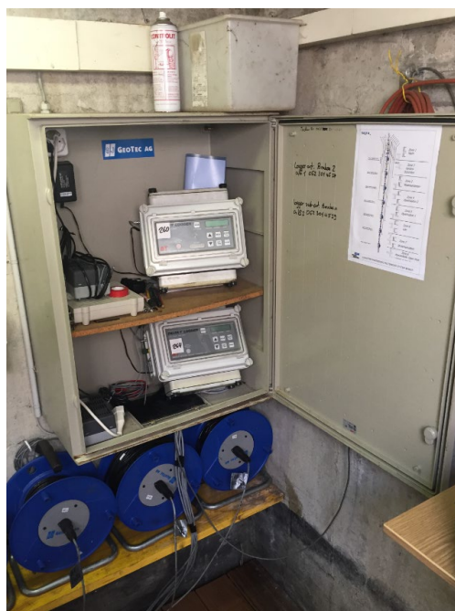
Figur 10: Messschrank mit den alten Datenloggern. Darunter Kabelrollen mit den Sensorkabeln.
