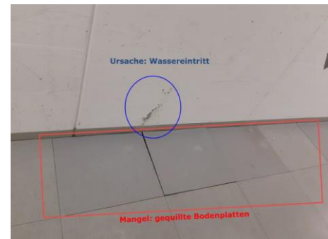
Abbildung 6: Schadenbild Hohlboden
