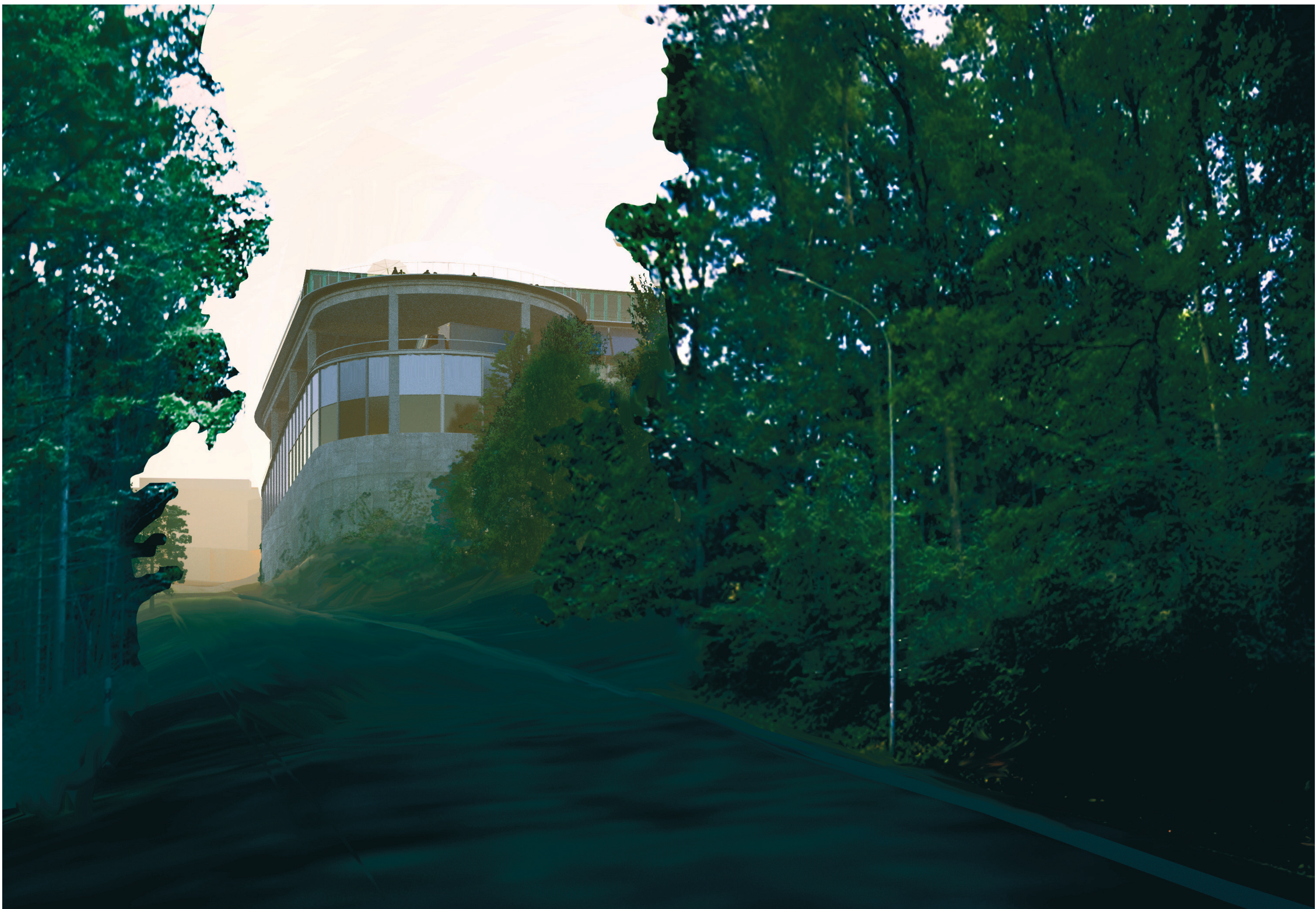
Das Gebäude sitzt an der Hankante zum bewaldeten Sittertobel. Blick von der Rechenstrasse.
