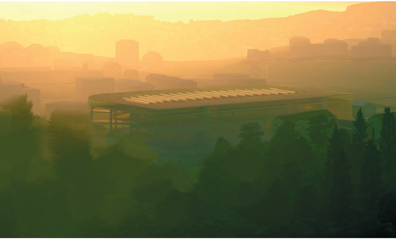
Das Dach als 5. Fassade mit PV Elementen auf den Sheds
