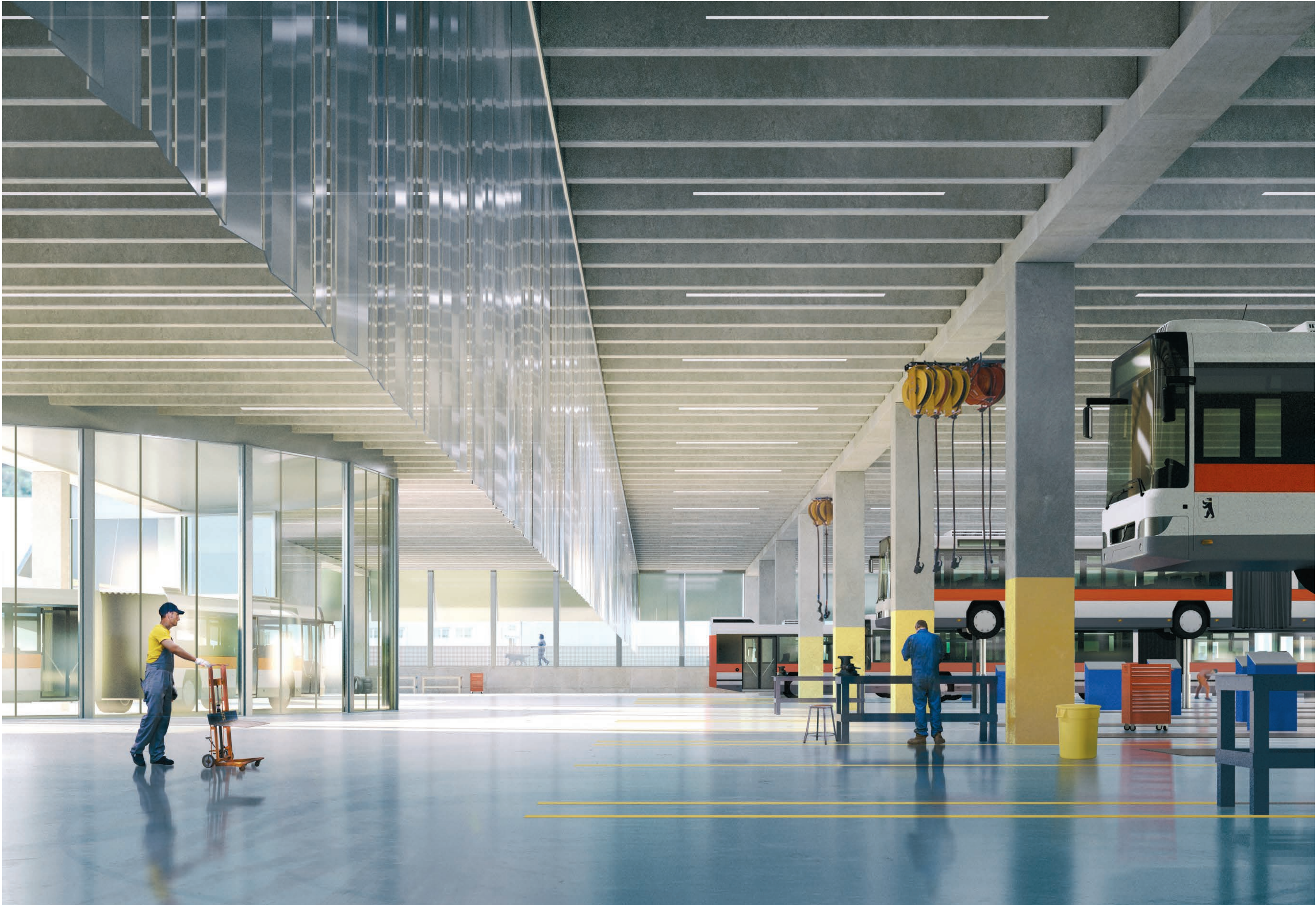
Die Werkstatthalle für die Busse im Erdgeschoss ist geprägt von grossen Spannweiten und einer Deckenstruktur aus vorfabrizierten Rippelementen.
