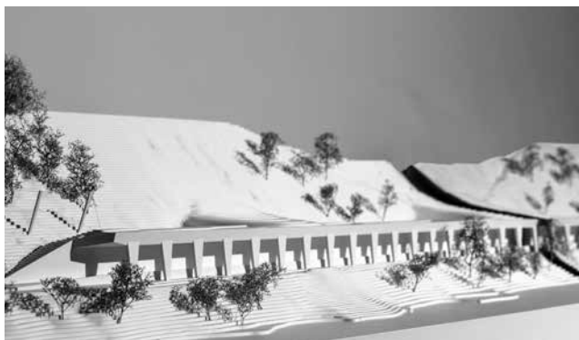
2. Platz «Svilup»: Der Wanderweg ist nicht vor dem Materialrückfluss geschützt; es gibt keine Leitmauer zwischen den Stützen. Durch das hangseits gerichtete Gefälle der Galeriedecke erscheint das Bauwerk grösser als die Galerien mit talseitigem Gefälle.
