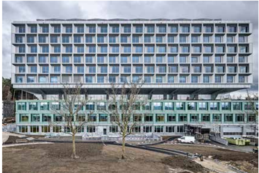
Aussenansicht des neuen Bettenhauses im Kantonsspital Frauenfeld .
