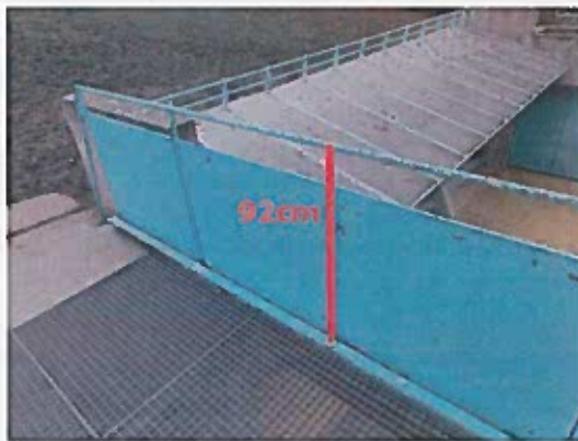
Photo 3 Balustrade passerelle Nord non conforme
