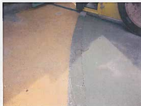
Photo 6 Revêtement extérieur dégradé
