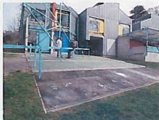
Photo 5 Revêtement dégradé devant l'entrée
