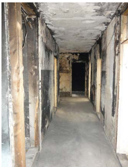
Dachgeschoss mit Brandschäden
