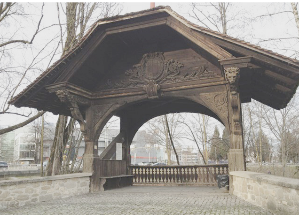
Die Holzbrücke am Seetalplatz
