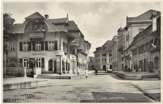
HOCHWASSERBEDINGTE ERHÖHTE GEHSTEIGE IM ZENTRUM VON LANGENTHAL
