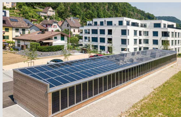
Der Velounterstand in Liestal mit integrierter AGROLA Solaranlage besticht durch eine gelungene, schöne Holz-Konstruktion. Rund 32 kWp werden jährlich produziert, was ausreicht, um ca. sechs bis sieben vierköpfige Familien mit Strom zu versorgen.
