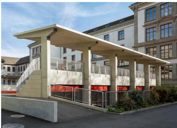
**Oben: der Bestand vor der Aufstockung.** Die Stützen an der Aussenseite der Fassade sind Blendstützen ohne statische Funktion.
