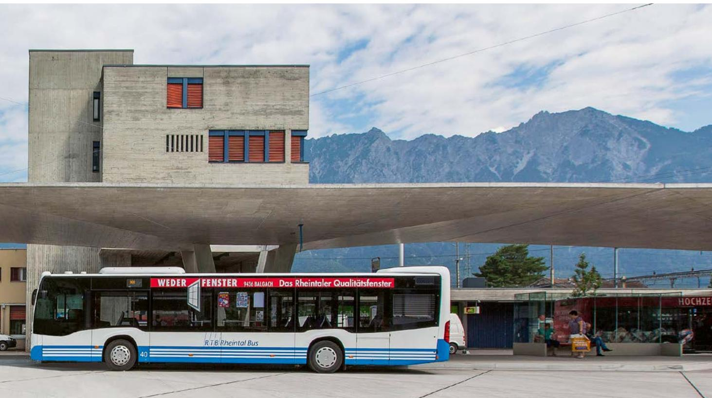
liche Abdichtung nötig – der wasserdichte Spannbeton erfüllt alle Anforderungen. Die Spannischen wurden nachträglich zubetoniert und die Arbeitsfugen mit Fugenbändern verklebt.
