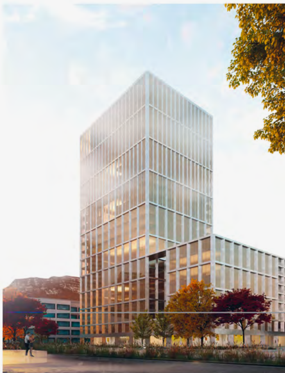
VUE DE L'EXTENSION DU SIÈGE DE LA BANQUE SUR LE BOULEVARD DES AGÈRES AU PETIT MATIN
