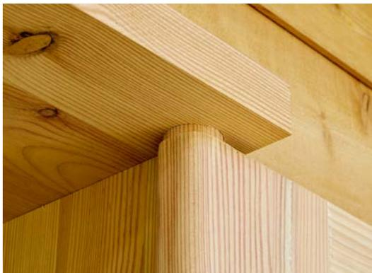
Die Fensterläden sind nach dem Vorbild traditioneller Steckverbindungen so befestigt, dass keine Metallteile nötig sind.
