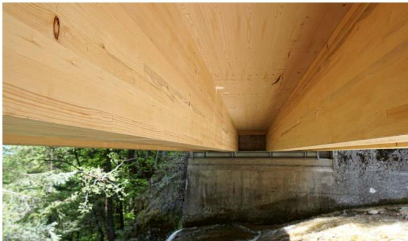
Ganz oben: **Querschnitt durch den Widerlagerbereich:** Zwischen den Holzträgern dienen Dreischichtplatten als verlorene Schalung.
