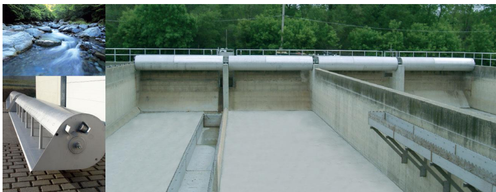
Figure 6.21 Exemples de photos d'augets basculants
