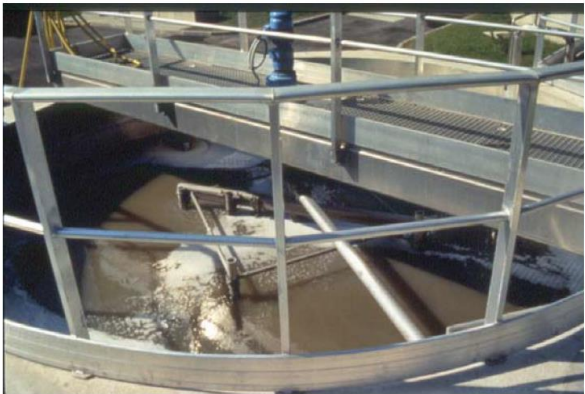
Figure 6.16 Vue et schéma d'un dessableur déshuileur circulaire.
