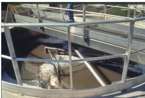
Figure 7.16 Vue et schéma d'un dessableur déshuileur circulaire.
