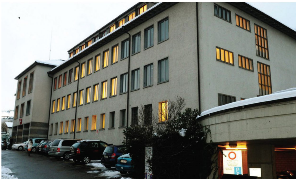
Aussenansicht Bezirksanlage Horgen
