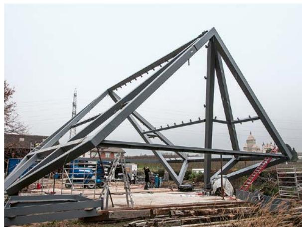
Das Exoskelett setzt sich aus 19 Hohlkastenprofilen und acht im Werk vorgefertigten Hohlkastenprofil-Elementen zusammen. Auf der Baustelle wurden die einzelnen Elemente zusammengesetzt, bevor die Holzbauteile in die Konstruktion eingefügt wurden.
