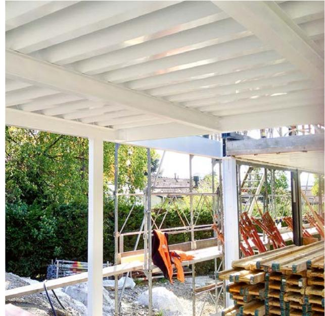
**Oben rechts:** Im Vordergrund ist die Decke des Carports zu sehen. Hier wird die Decke von zusätzlichen Trägern unterstützt. Im hinteren Bildbereich (rechts) erkennt man die Stahl-Beton-Verbunddecke, für die die Cofra-Bleche als Schalung, aber auch als optische Verbindung der Räume dienen.
